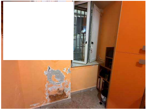
Presenza di umidità con distacco di intonaco
