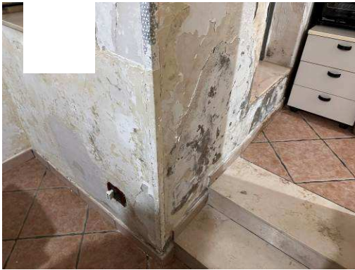
Presenza di umidità con distacco di intonaco
