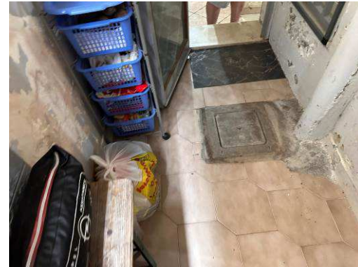
Pozzetti neri di ispezione
