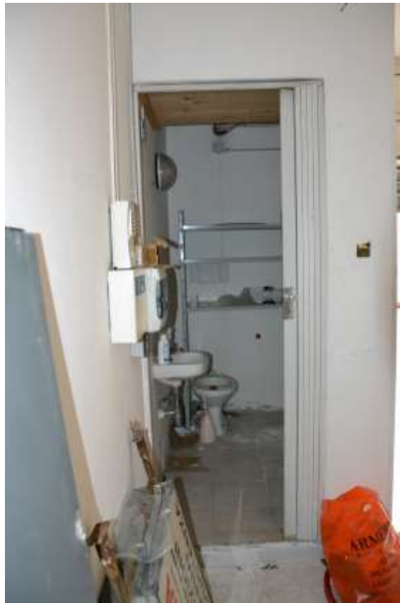
Vista interno - bagno
