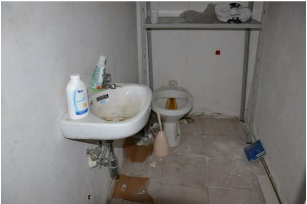
Vista interno - particolare bagno
