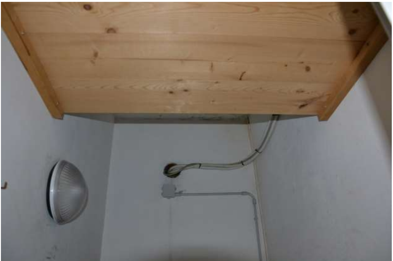
Vista interno - soppalcatura bagno
