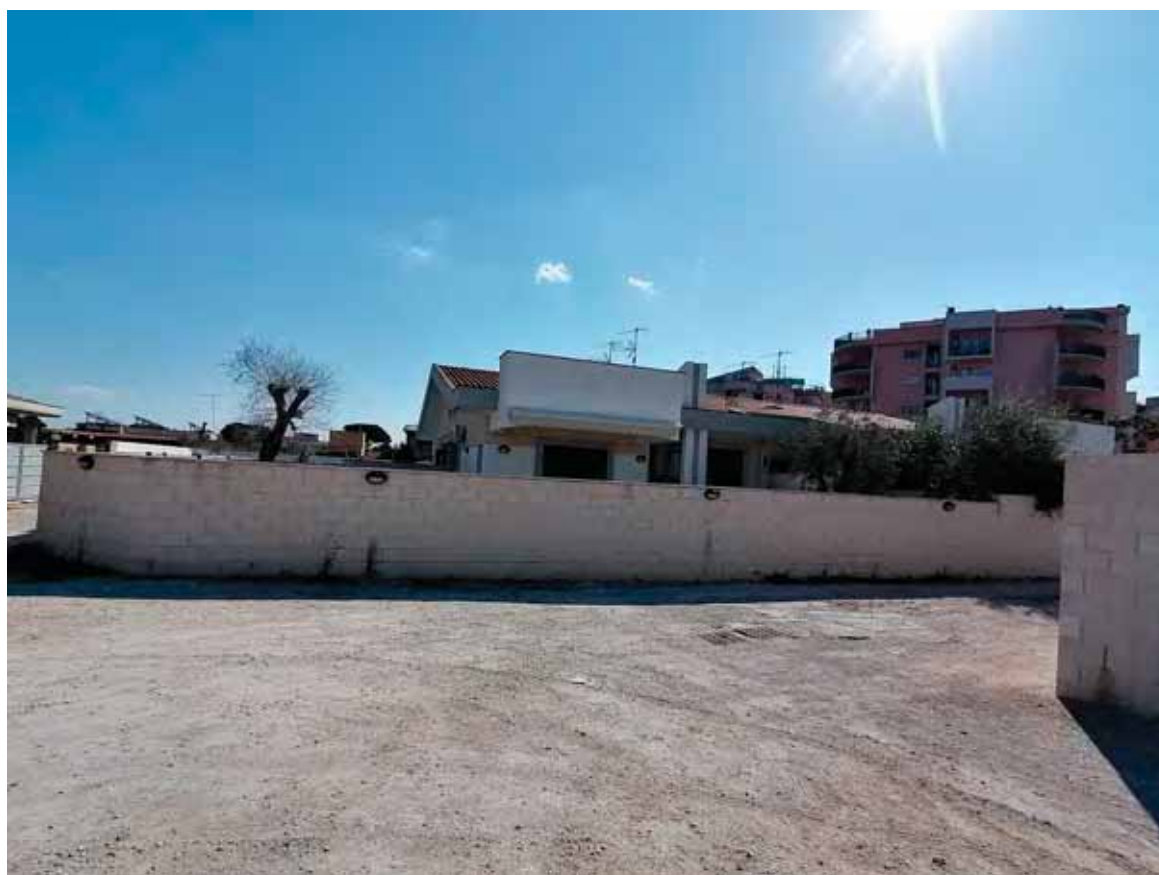
FOTO N. 1: Particolare esterno immobile
