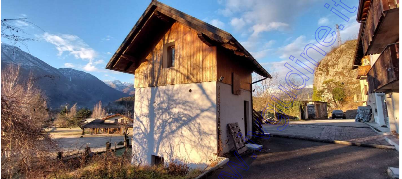
Vista esterna foto 7 (deposito)
