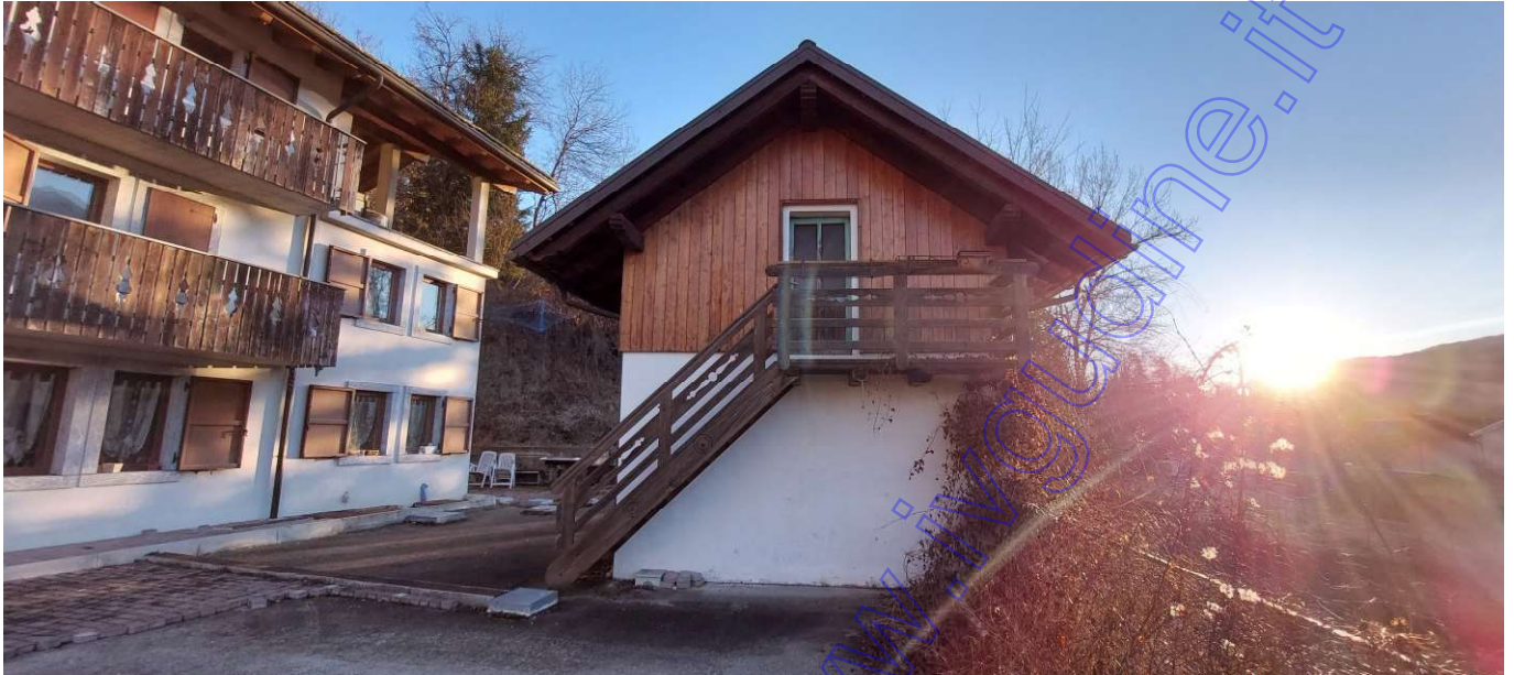
Vista esterna foto 5 (deposito)
