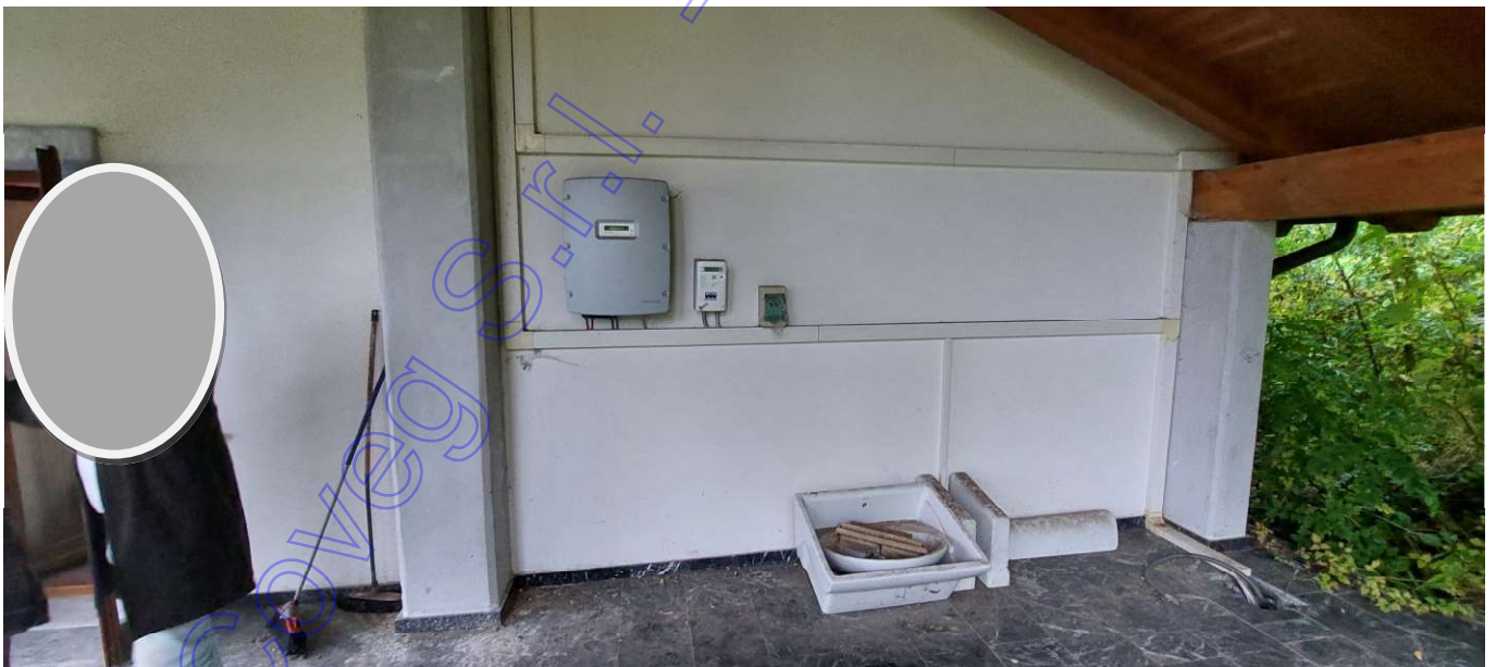
Vista interna foto 18 (terrazza coperta)
