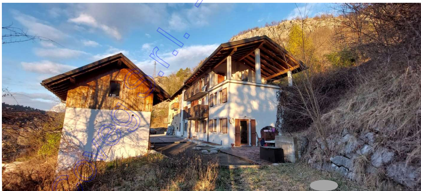
Vista esterna foto 4 (abitazione)
