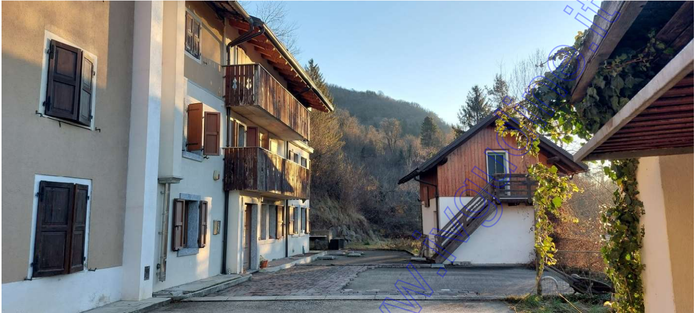
Vista esterna foto 1 (abitazione)
