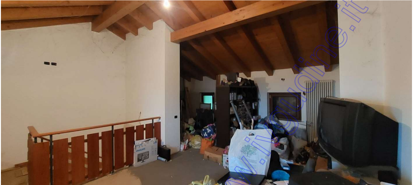
Vista interna foto 17 (soffitta al grezzo)
