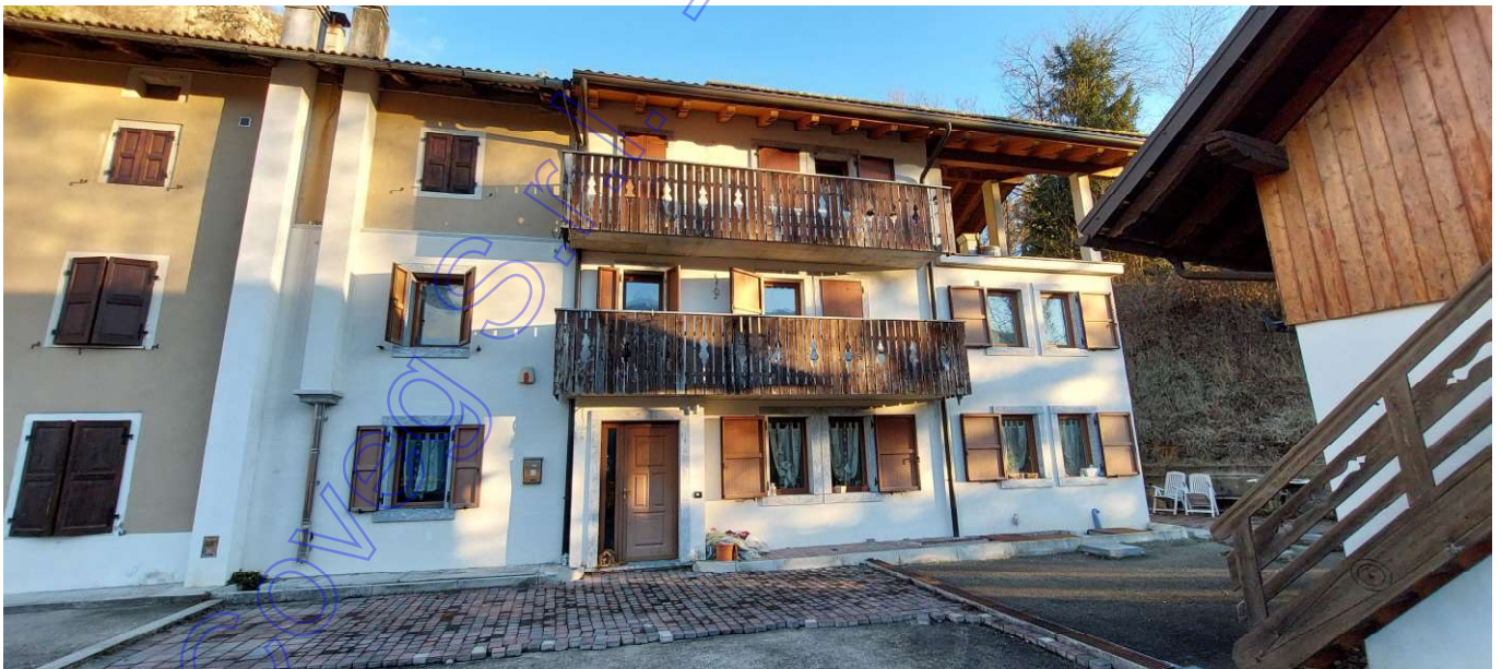
Vista esterna foto 2 (abitazione)
