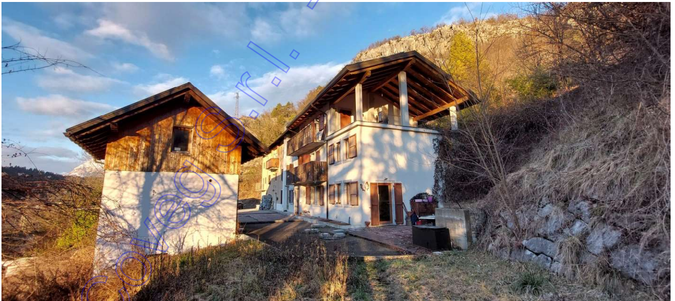
Vista esterna foto 6 (deposito)
