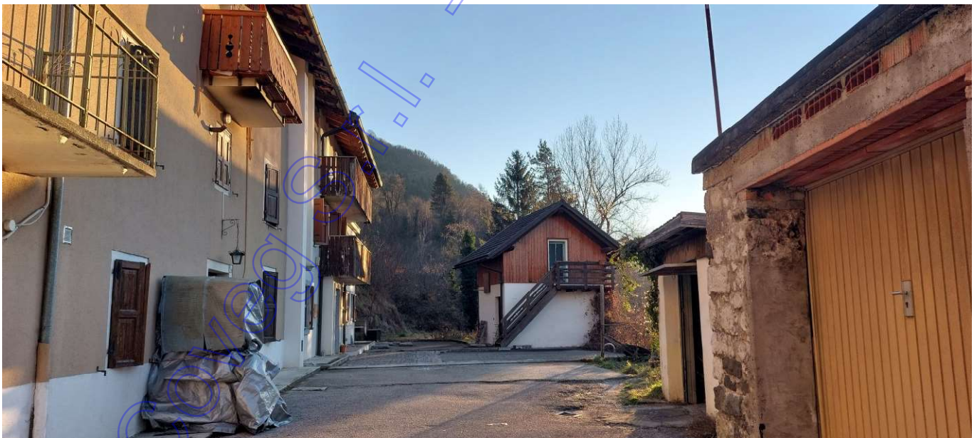
Vista esterna foto 8 (deposito)
