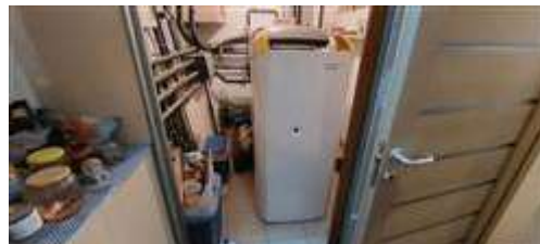
Vista interna abitazione (foto 6)
