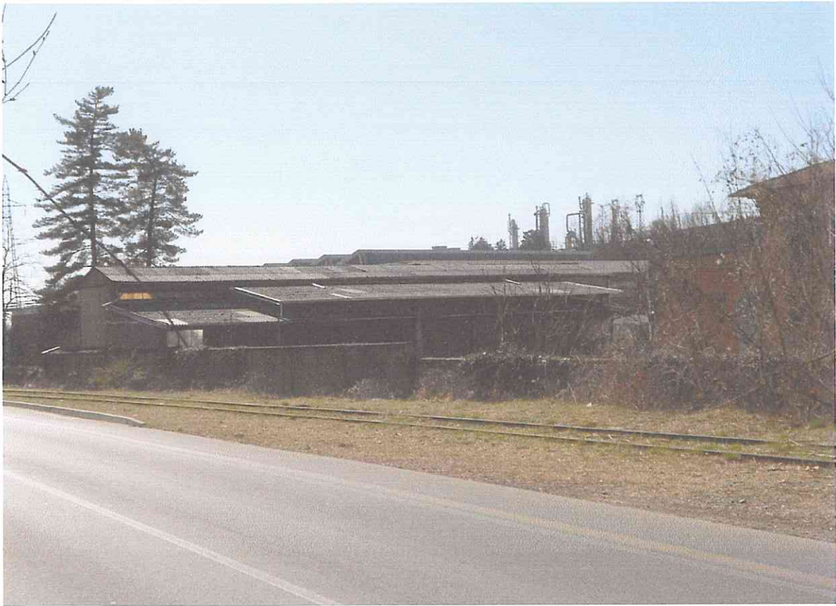
Foto 3- Vista da Nord-Est della Manifattura DELL'ACQUA, ricadente in Gorla Min.: stato di fatto
