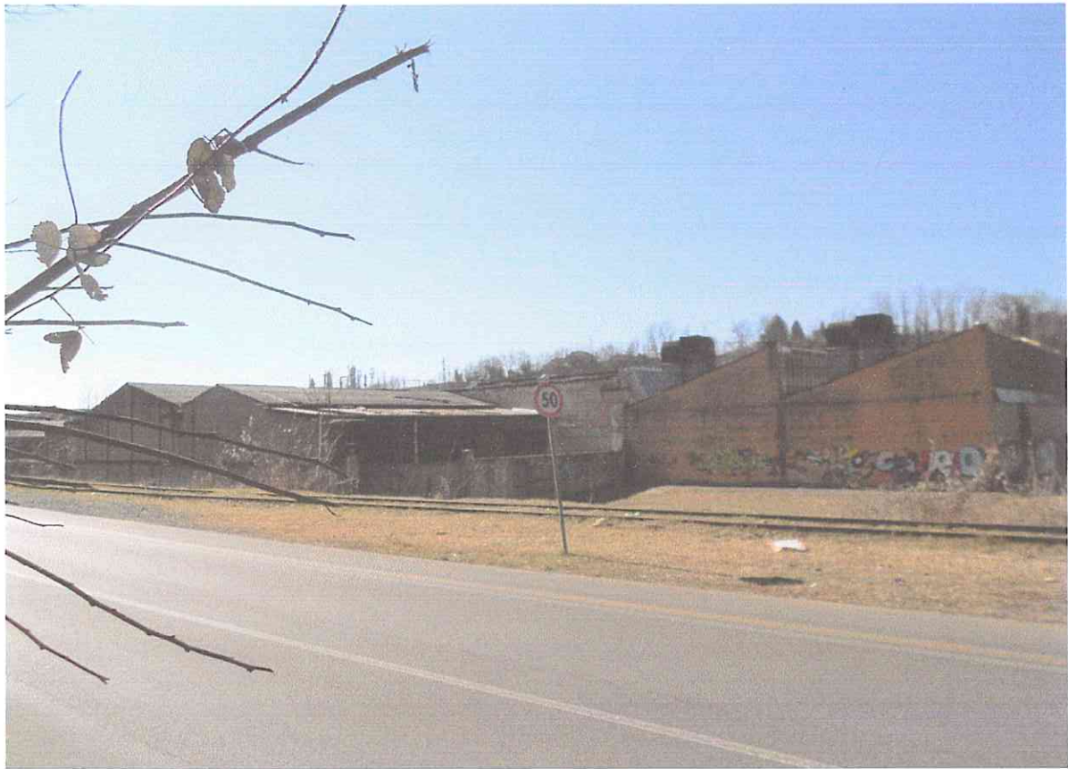
Foto 1- Vista da Nord-Est della Manifattura DELL'ACQUA, ricadente in Solbiate O.: stato di fatto
