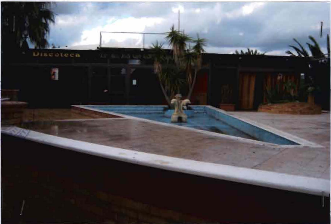
FOTO N° 9 PROSPETTO OVEST BALERA
