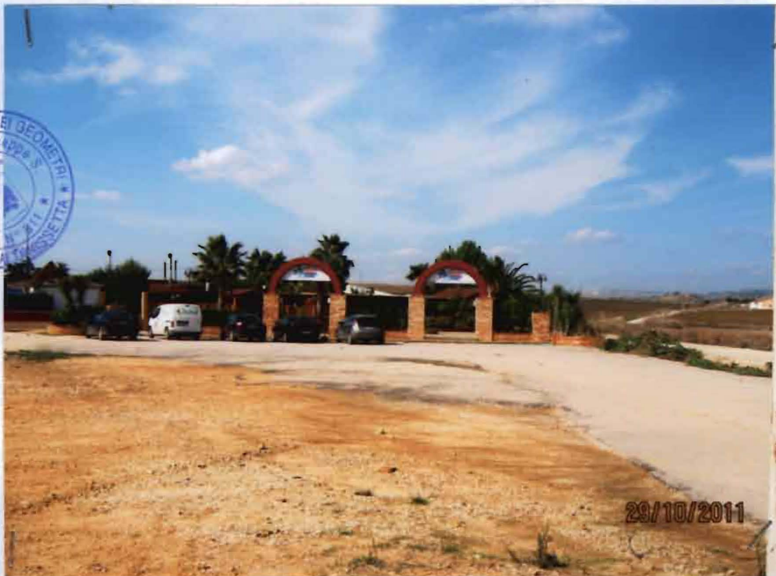
FOTO N° 2 PROSPETTO OVEST - INGRESSO PRINCIPALE
