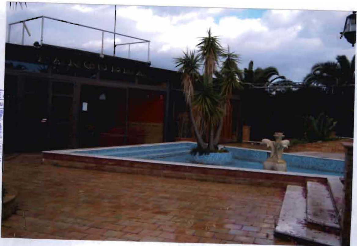
FOTO N° 10 PROSPETTO OVEST - BALERA
