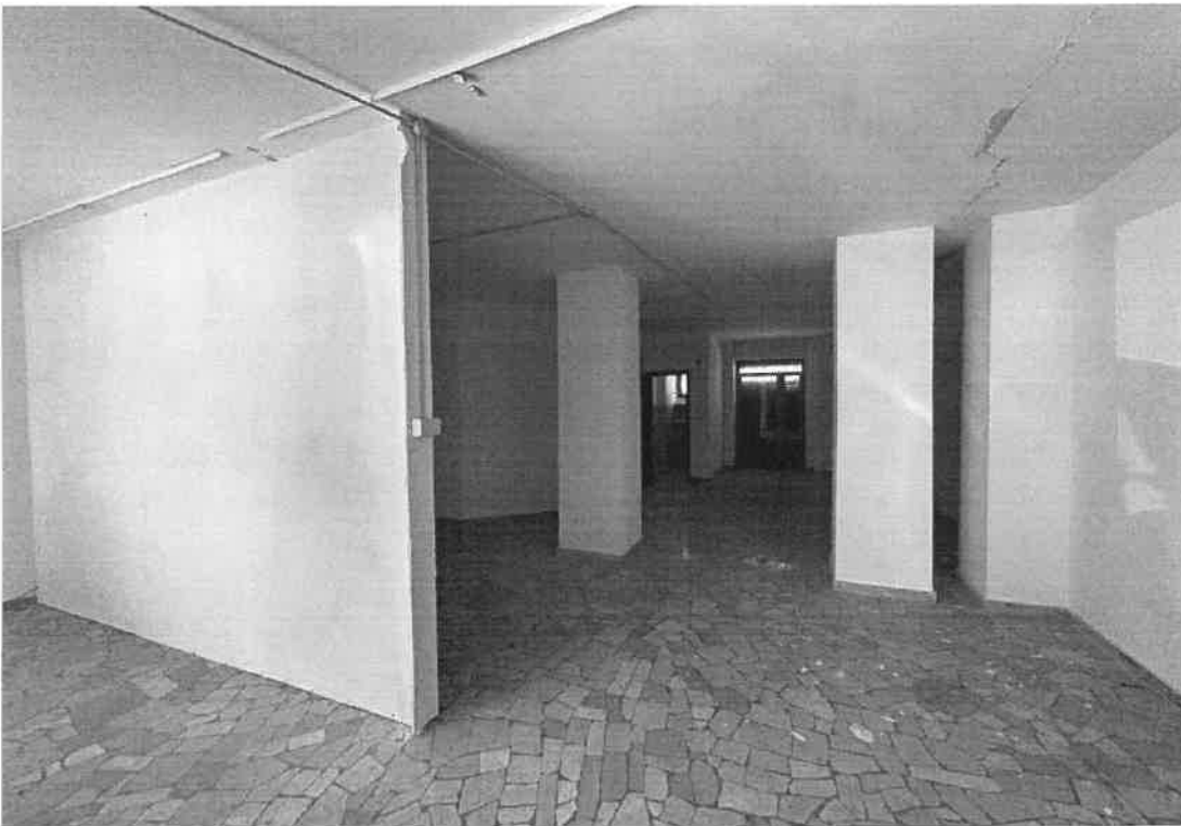
Fig.5 interno dell'immobile dove si vede con chiarezza che l'immobile adesso è unico
