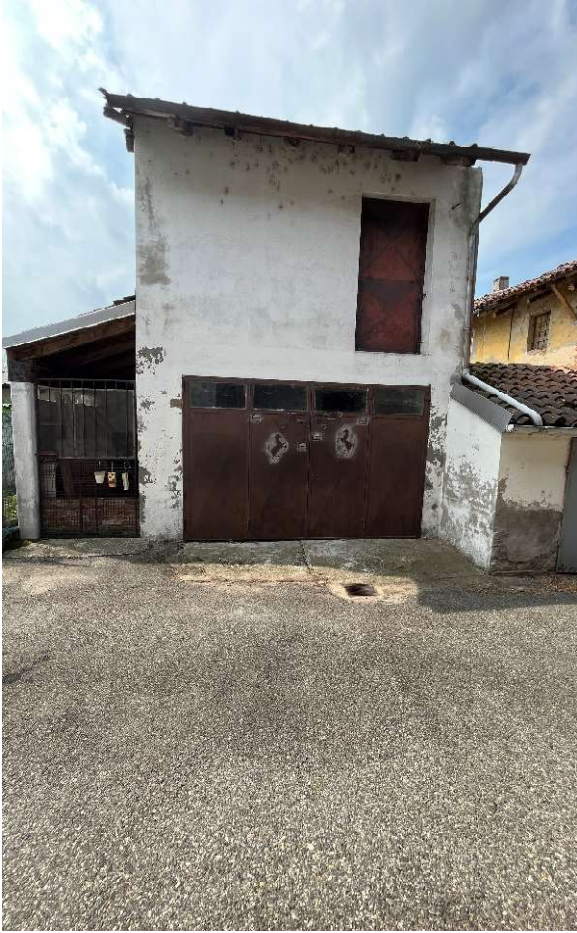
VISTA DEL FRONTE NORD DELL'AUTORIMESSA
