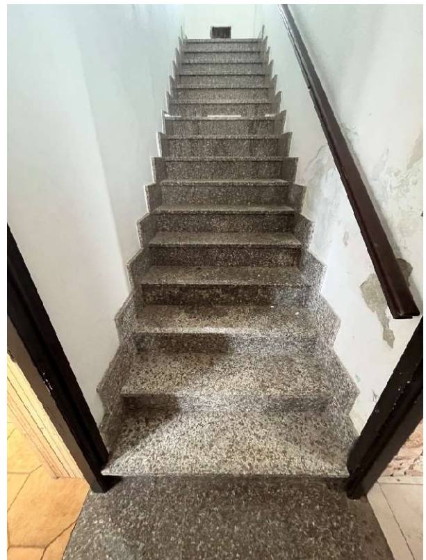
VISTA SCALA DI ACCESSO A P.1°
