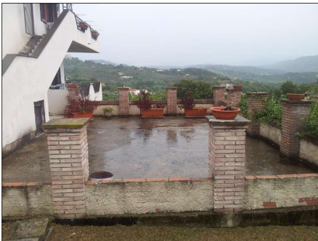
Foto 4 – Vista esterna – Terrazzo esclusivo piano terra
