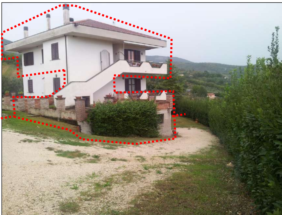
Foto 2 – Vista esterna lati nord-est
