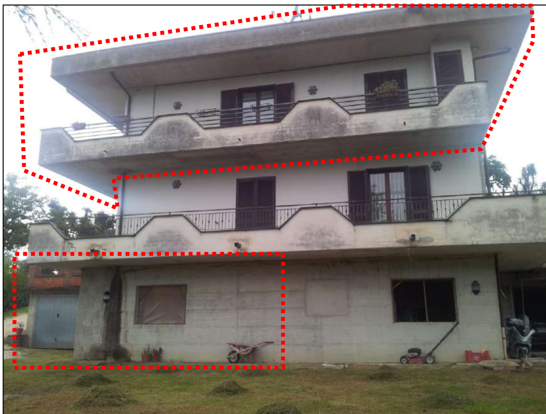
Foto 3 – Vista esterna lato sud
