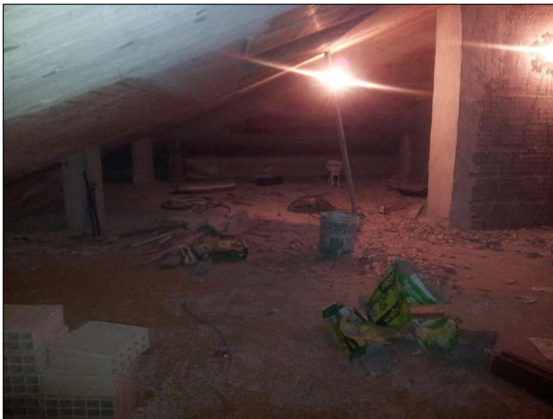
Foto 10 – Vista interna appartamento - piano sottotetto
