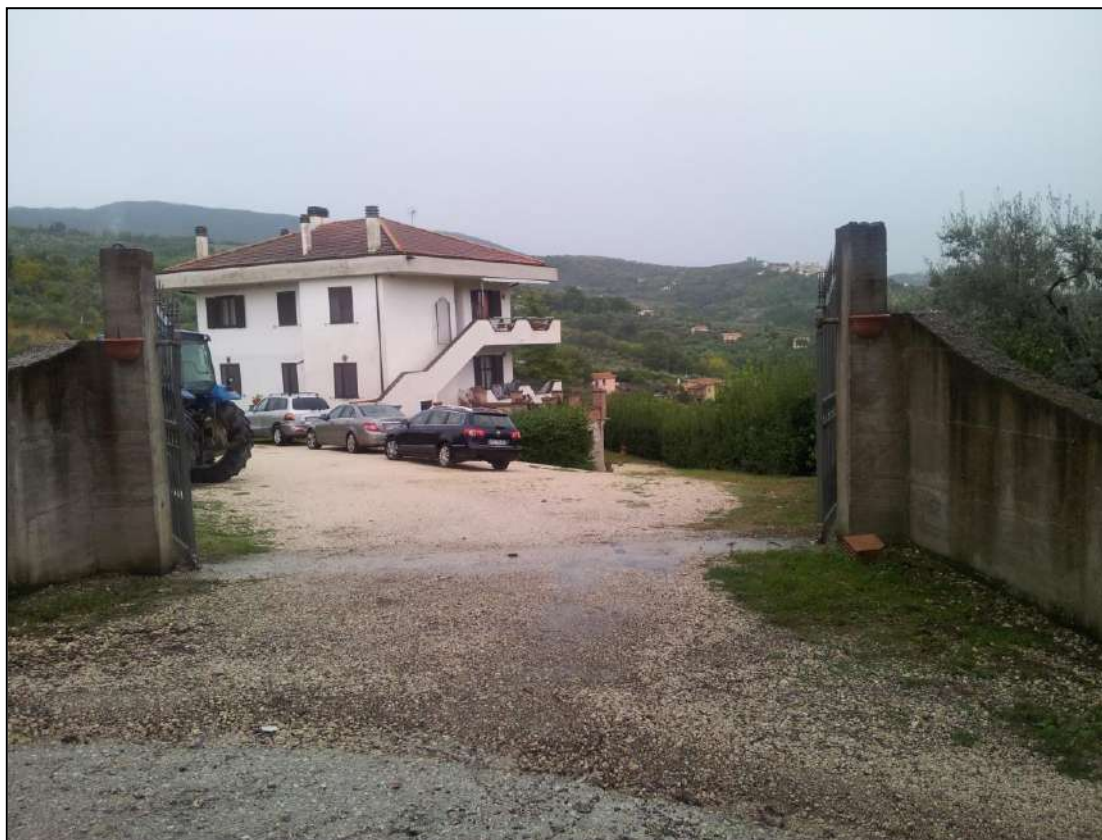
Foto 1 – Vista ingresso carrabile sulla corte del fabbricato da Via Paradiso
