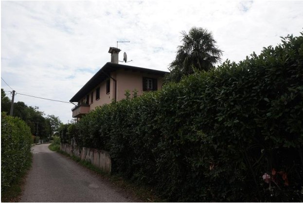
Vista da nord/ovest (da Via S. Marco)
