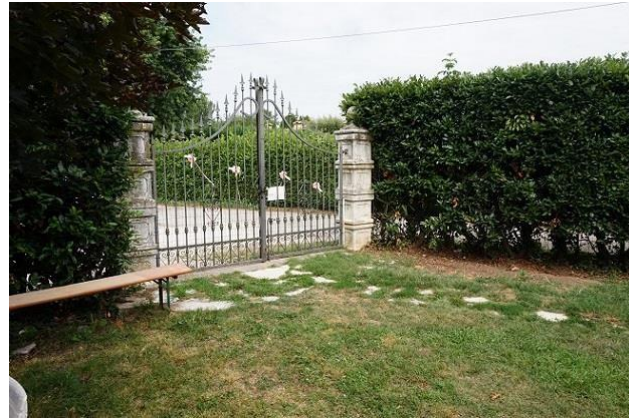
Ingresso pedonale e carraio fronte ovest da corte
