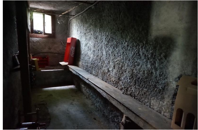
Piano seminterrato: cantina
