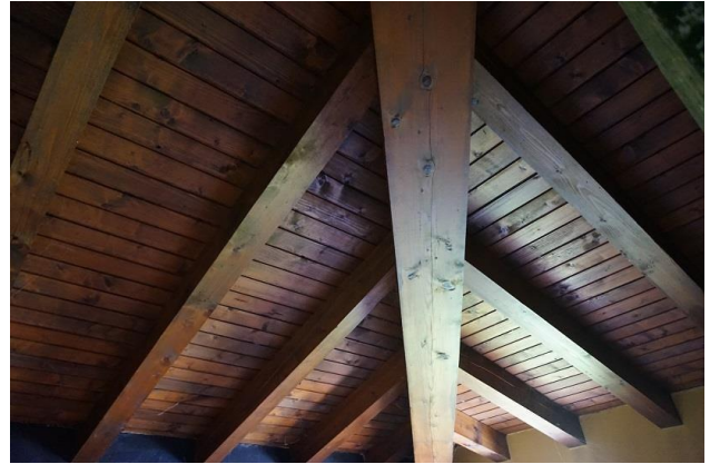
Piano primo: particolare tetto a vista
