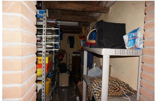
Piano seminterrato: ripostiglio a nord
