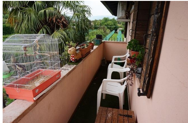
Piano primo: terrazza lato ovest
