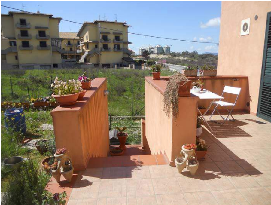
Foto 7 – Immobile di Corso Risorgimento n.45 – terrazzo/corte piano primo
