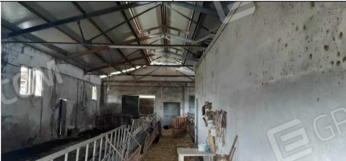
Unità immobiliare destinata a stalla – Particella n° 305/307, sub. 1
