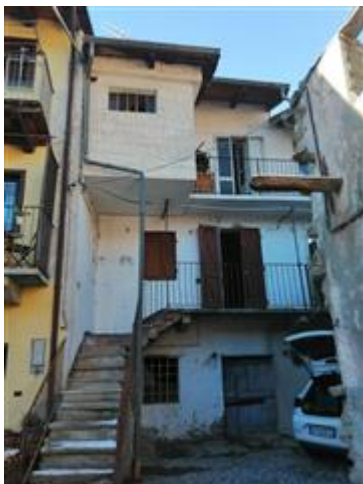
Prospetto nord-est dell'immobile pignorato
