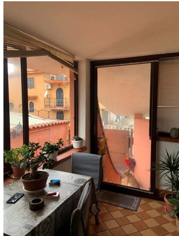
Terrazzo al piano rialzato trasformato in vano chiuso mediante infissi/veranda
