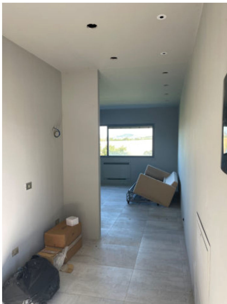
Foto n° 15: interno dell'unità immobiliare n° 38/504 – cat A/2
