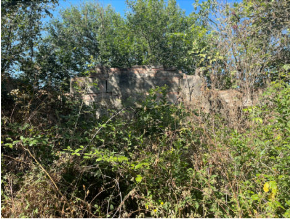
Foto n°23: fabbricato collabente ( unità immobiliare n° 646 )
