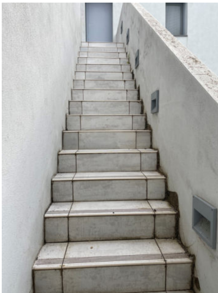
Foto n° 13: scale di accesso al piano primo
