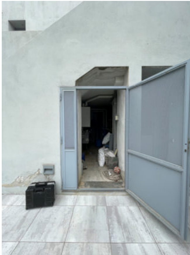
Foto n° 25 : Locale tecnico condominiale
