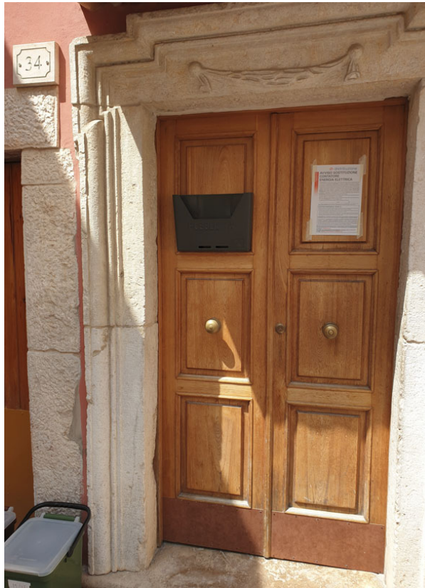
Figura 6: accesso condominiale. Anche se riportato in Catasto il n° civico 77, la targa esposta presenta il n° 34.
