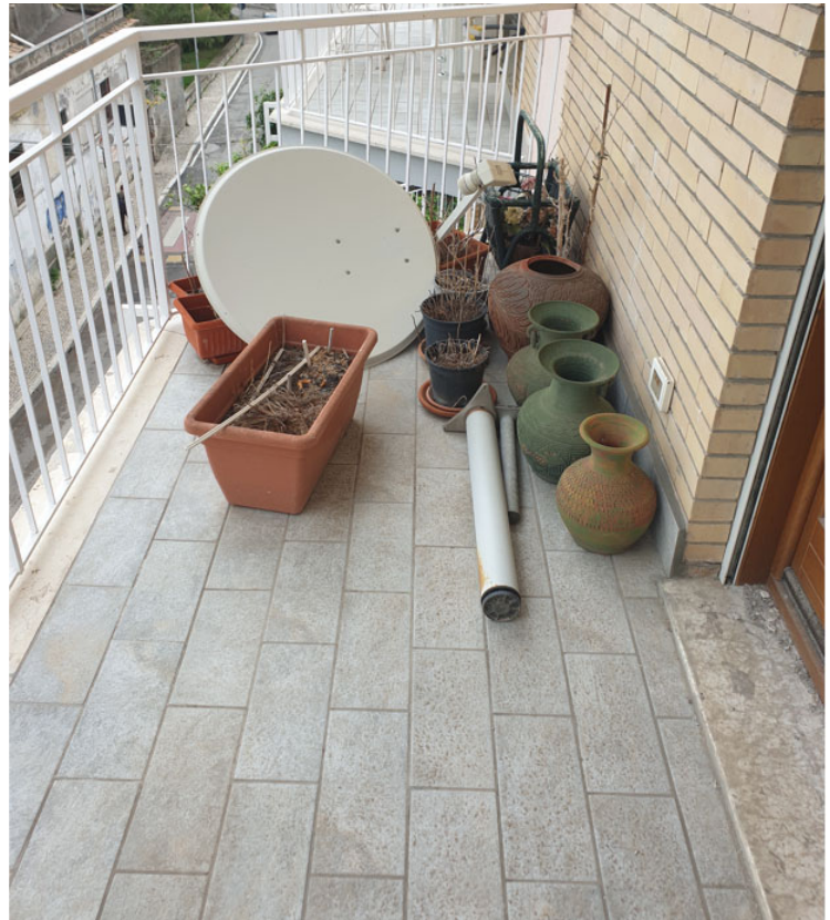
Figura 22: terrazzo parte frontale
