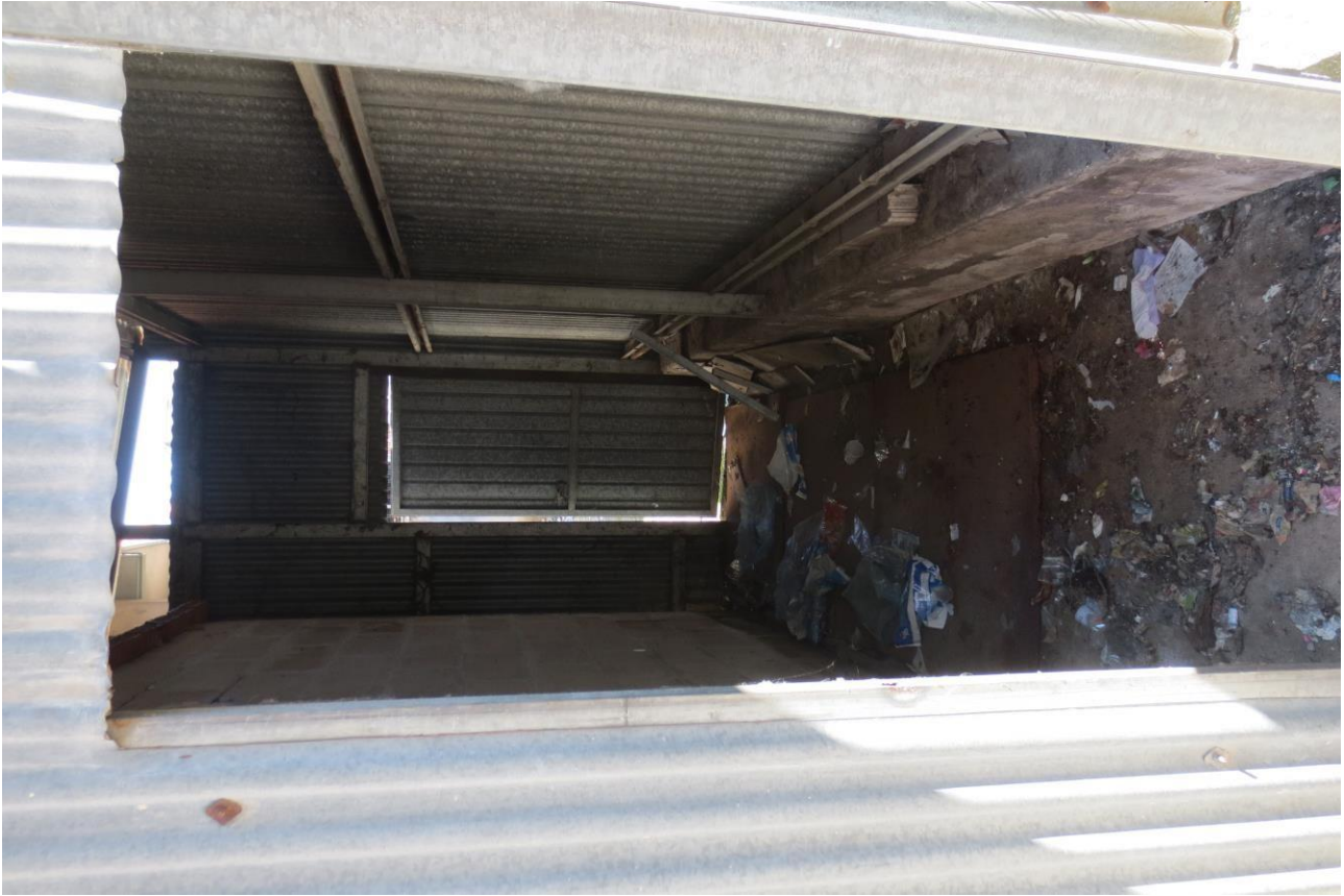
Foto n. 13 - LOTTO N. 2 - Vista Interna
