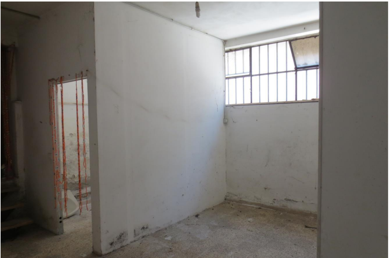
Foto n. 22 - LOTTO N. 4 - Vista Interna
