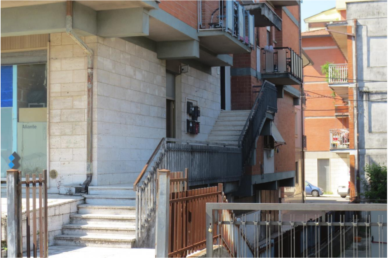
Foto n. 15 - LOTTO N. 3 - Vista Esterna
