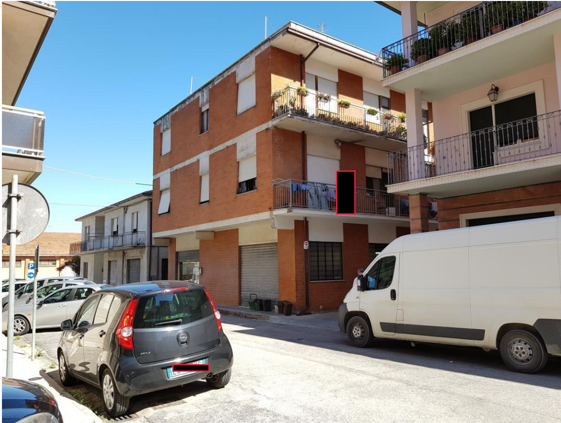
Foto n. 01 - LOTTO N. 1 - Vista Esterna
