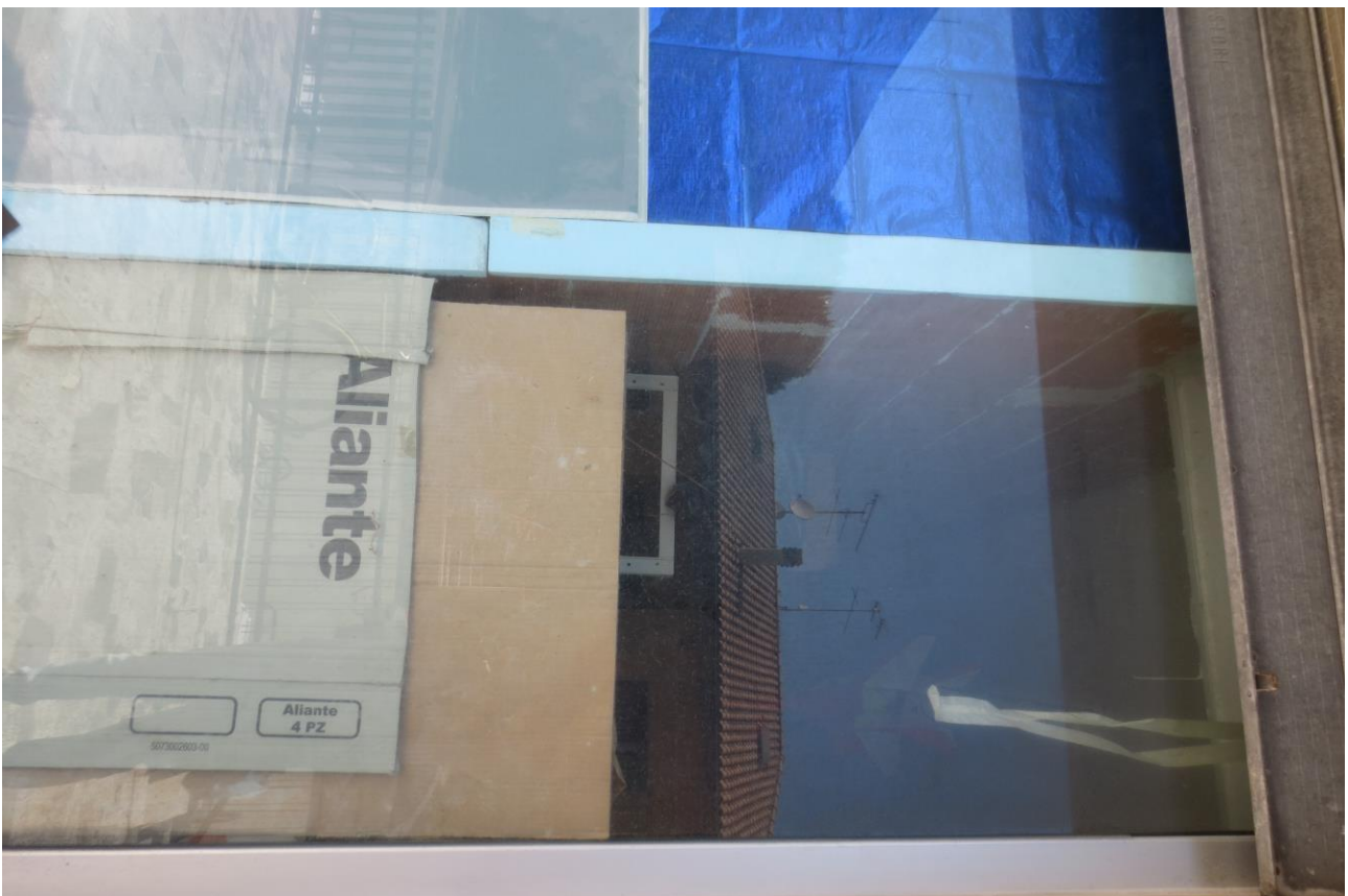
Foto n. 16 - LOTTO N. 3 - Vista Esterna
