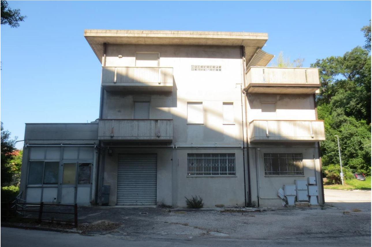
Foto n. 25 - LOTTO N. 5 - Vista Esterna
