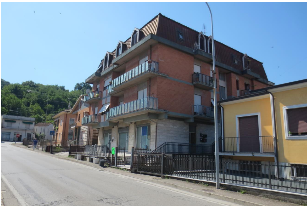
Foto n. 08 - EDIFICIO LOTTI N. 2-3-4 - Vista Esterna
