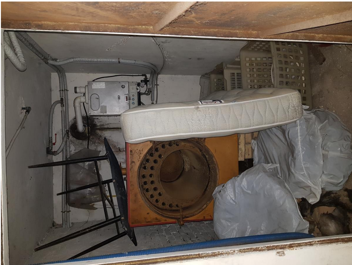
Foto n. 06 - LOTTO N. 1 - Vista Interna
