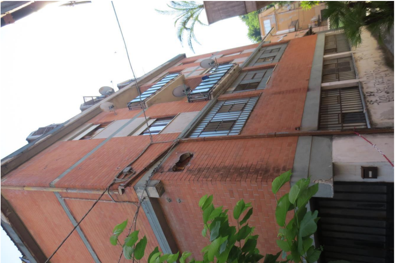
Foto n. 09 - EDIFICIO LOTTI N. 2-3-4 - Vista Esterna
