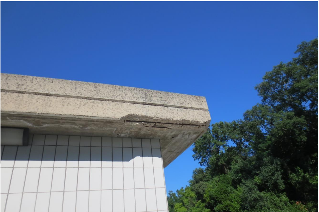
Foto n. 38 - LOTTO N. 5 - Copertura Vano Scala
