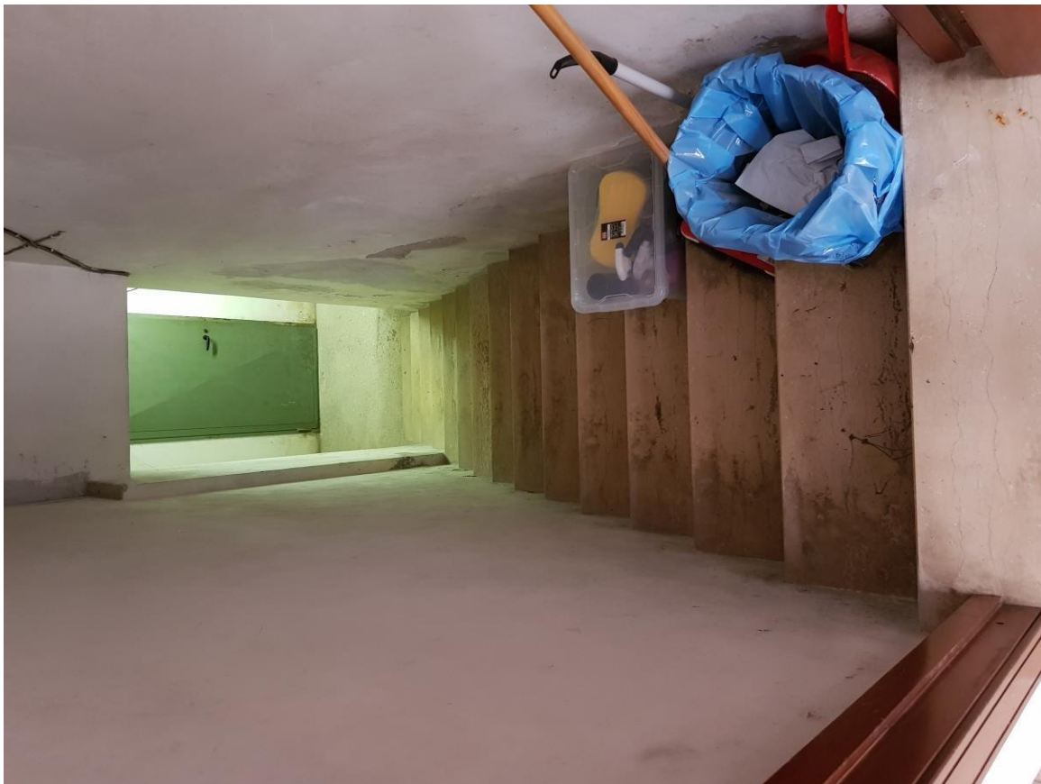
Foto n. 04 - LOTTO N. 1 - Scala condominiale
