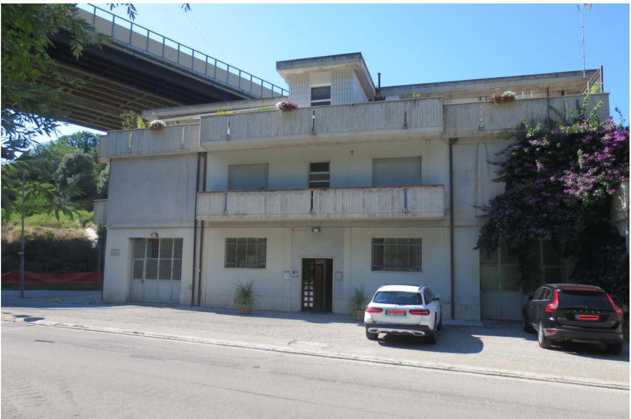
Foto n. 24 - LOTTO N. 5 - Vista Esterna
