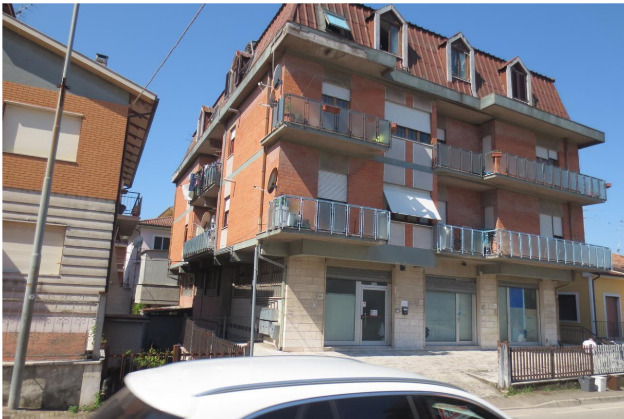
Foto n. 07 - EDIFICIO LOTTI N. 2-3-4 - Vista Esterna
