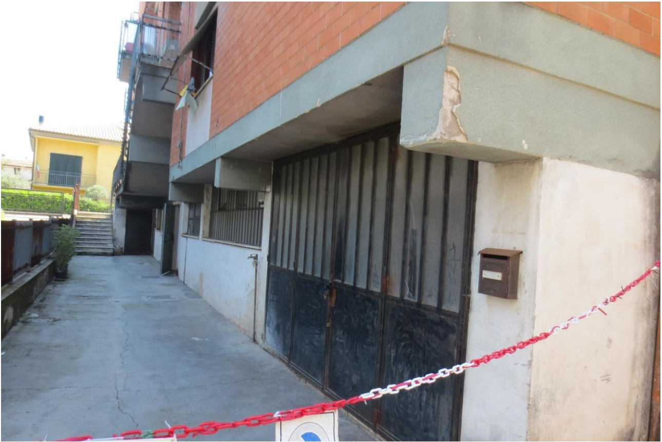
Foto n. 19 - LOTTO N. 4 - Vista Esterna
