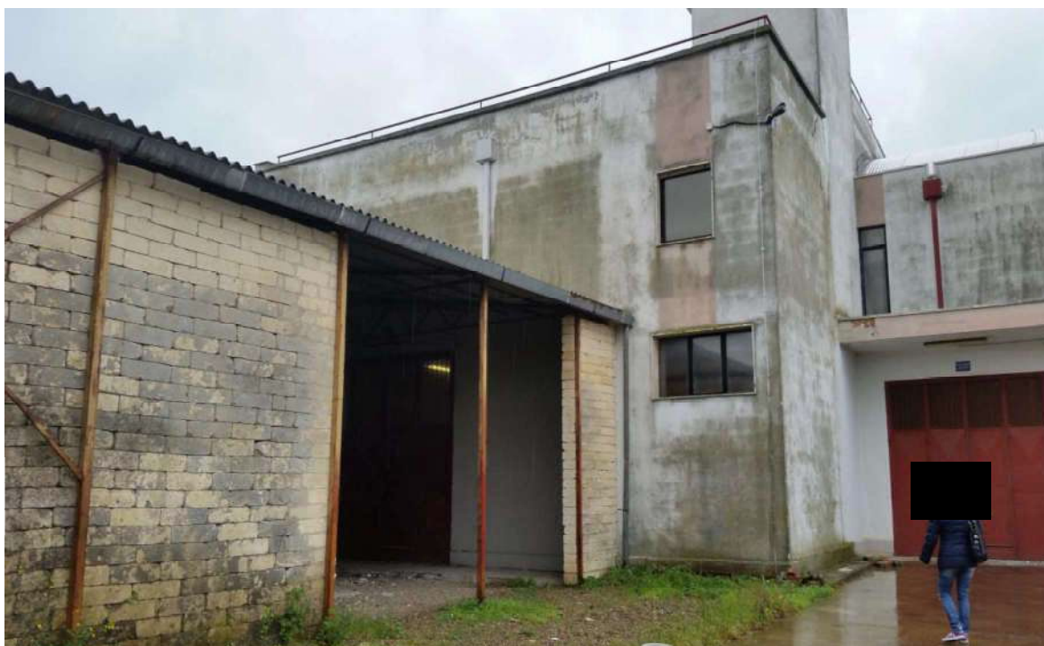
Foto 4: Degrado dei prospetti. Locale deposito con copertura in cemento-amianto
