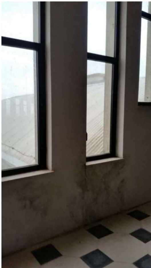
Foto 13: Infiltrazione e degrado nel locale seminterrato
