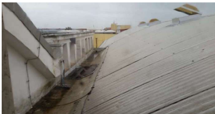
Foto 4: Degrado dei prospetti. Locale deposito con copertura in cemento-amianto
