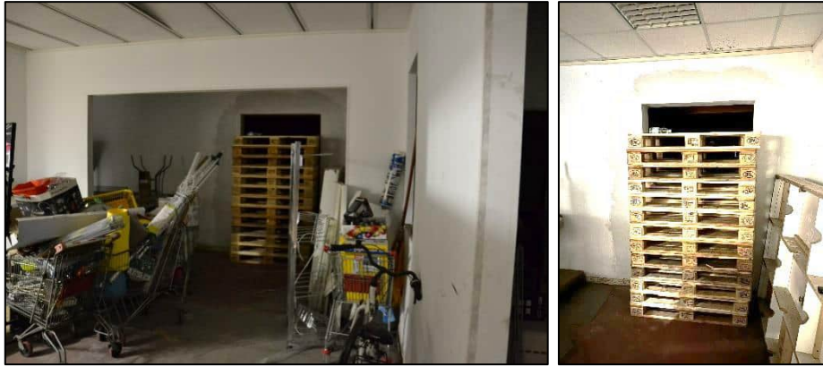
Figura 13 - Apertura di collegamento con altra unità immobiliare estranea alla procedura
