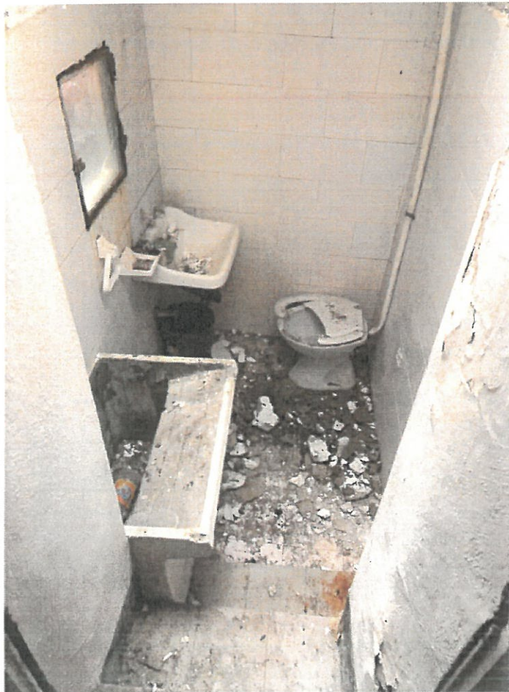
Foto n° 30 veduta wc p. 2° lotto 2
