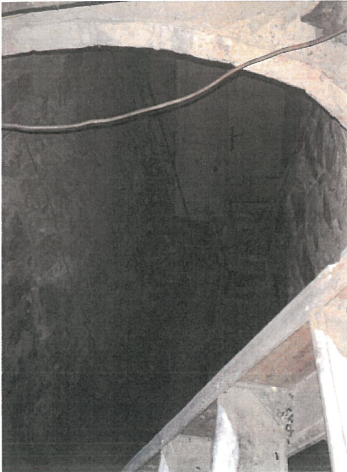
Foto n° 33 veduta cantine lotto 2
