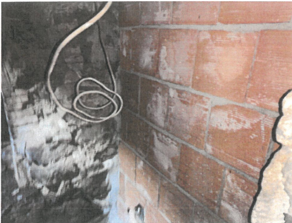
Foto n° 37 veduta cantine lotto 2
