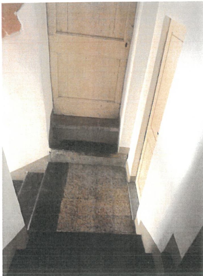
Foto n° 28 veduta interna vano scala accesso magazzino piano primo lotto 1 e cantina lotto 2
