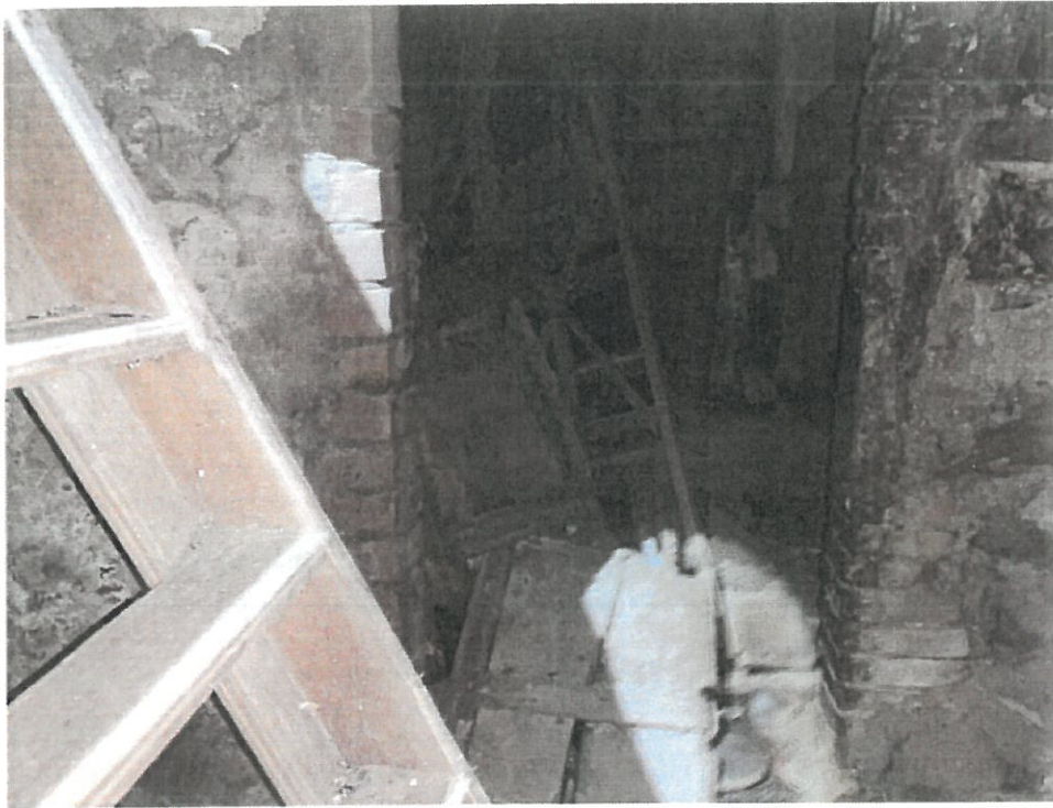
Foto n° 38 veduta cantine lotto 2
