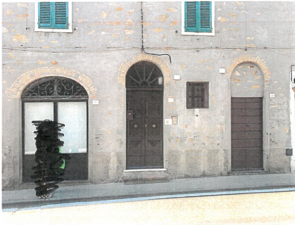
Foto n° 2 veduta esterna lotti 1 e 2
