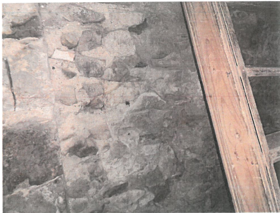
Foto n° 39 veduta cantine lotto 2
