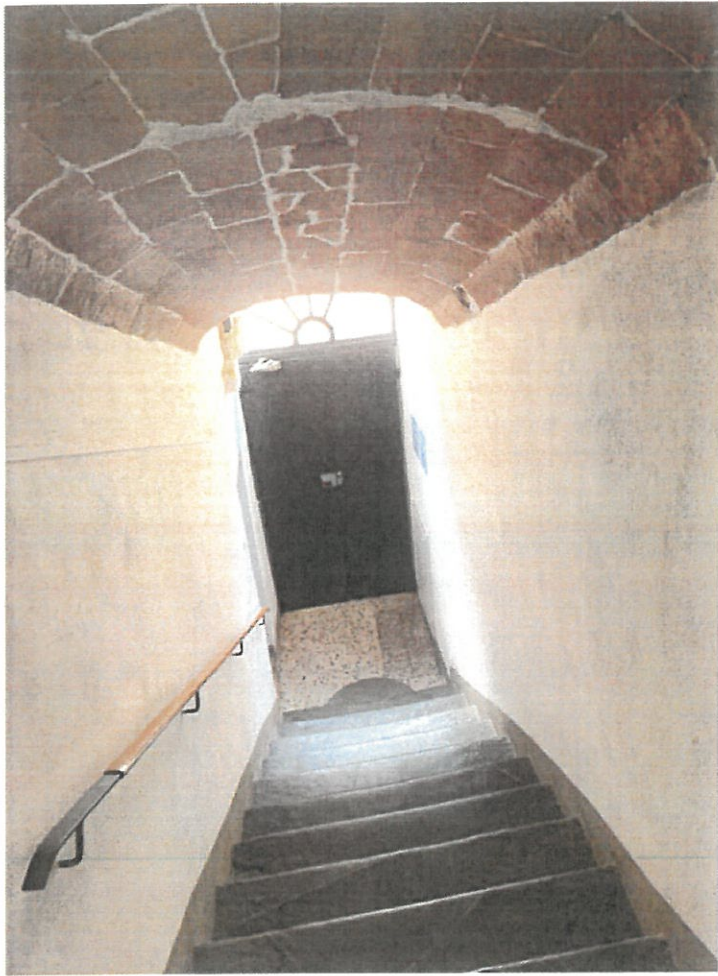
Foto n° 29 veduta interna vano scala
