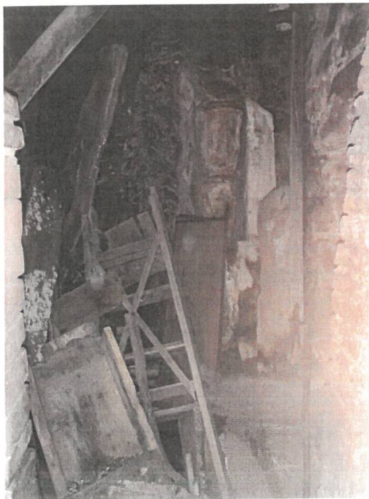
Foto n° 35 veduta cantine lotto 2
