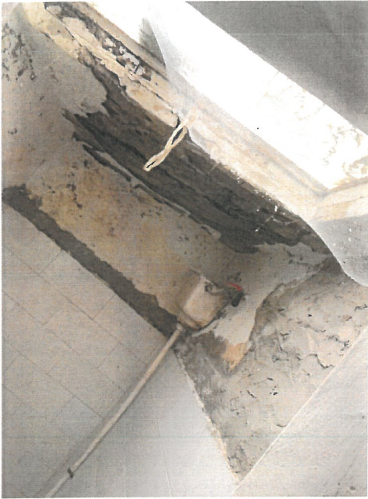
Foto n° 32 veduta wc p. 2° lotto 2
