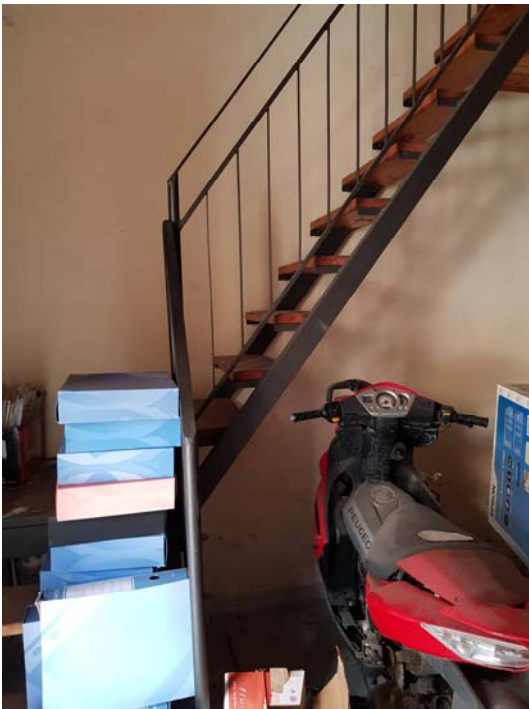
Vista della scala di accesso al soppalc
