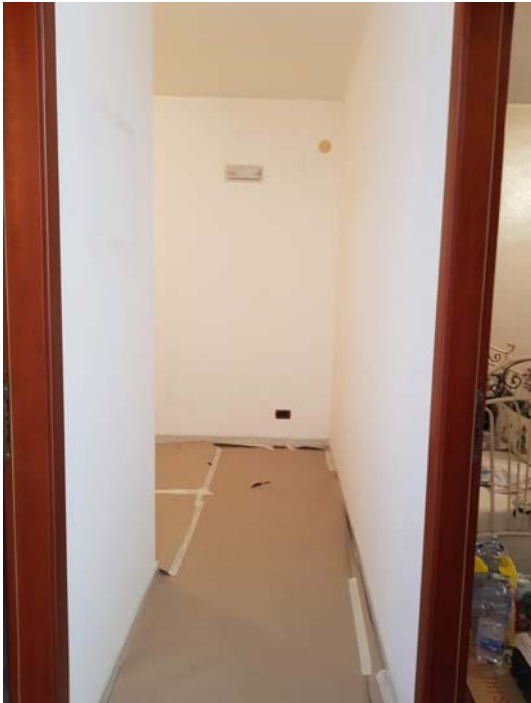
Vista del disimpegno (Dis)
