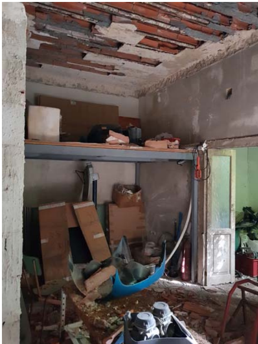
Vista del deposito (D1)
