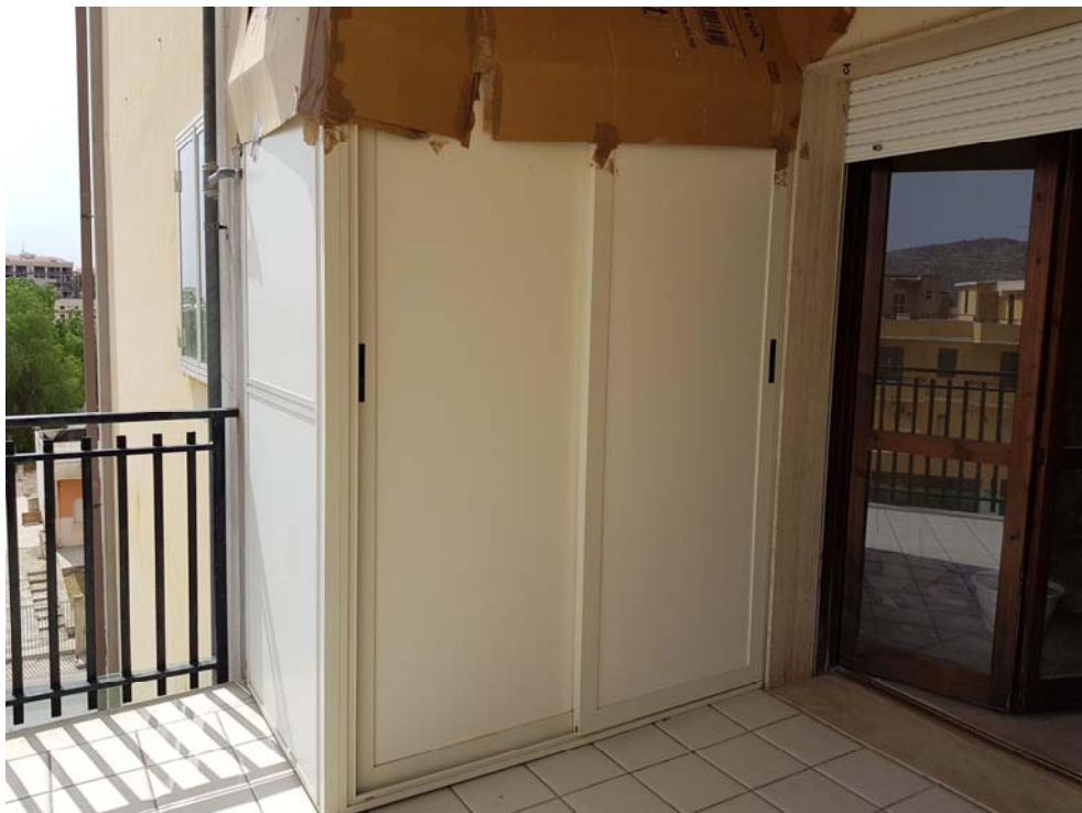
Vista del balcone (B)
