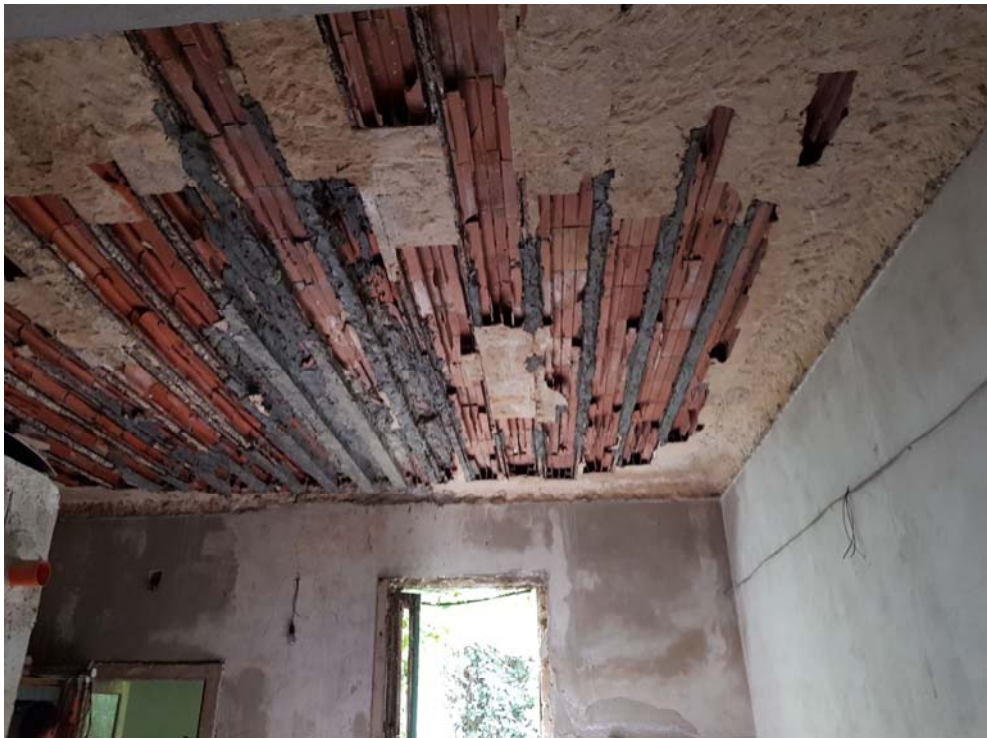
Vista del solaio del deposito (D1)
