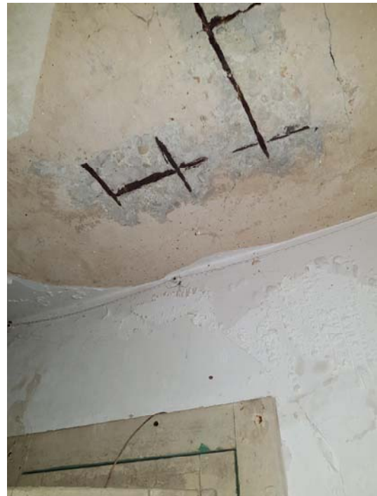
Vista della copertura del servizio igienico (Wc)
