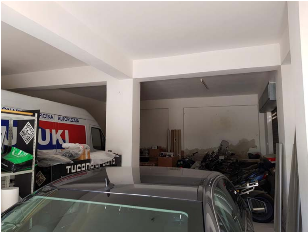
Vista del deposito (D1)
