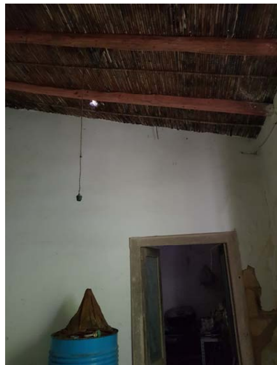
Vista della copertura del deposito (D2)
