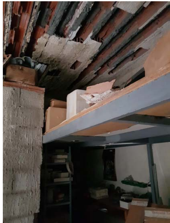
Vista del solaio del deposito (D1)
