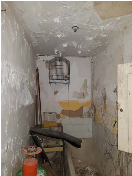
Vista del servizio igienico (Wc)
