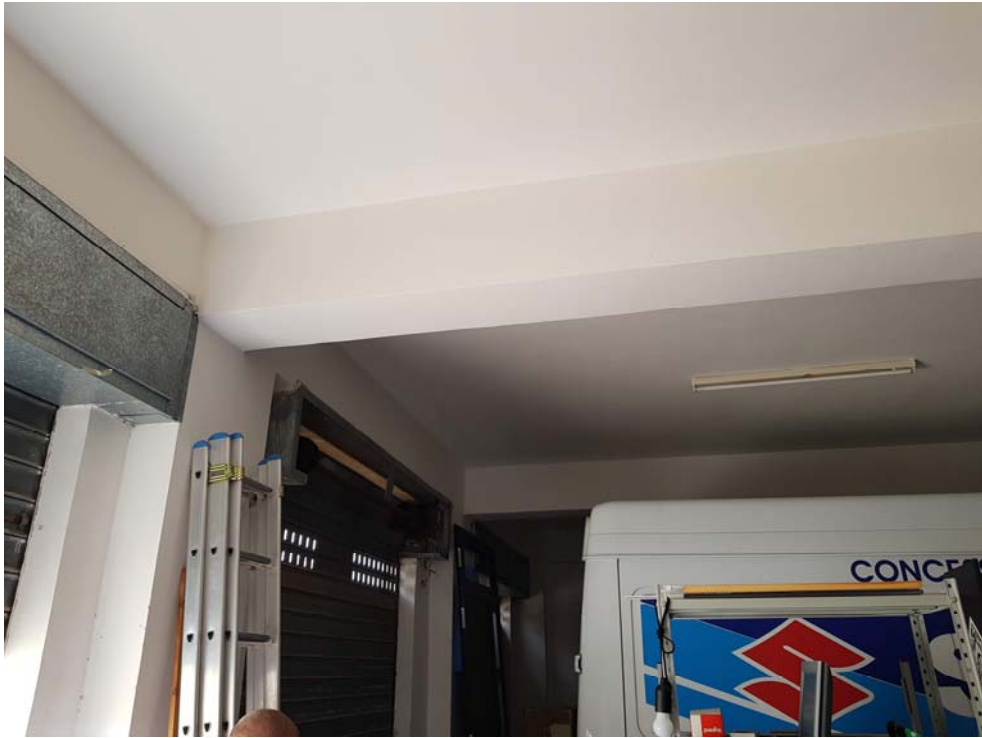
Vista del deposito (D1)
