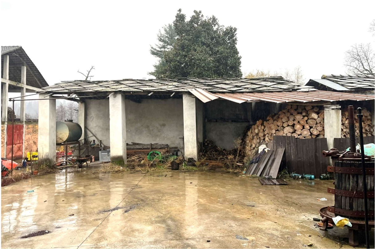
Foto n.6 Vista del Bene n.3 (Tettoia) dal cortile
