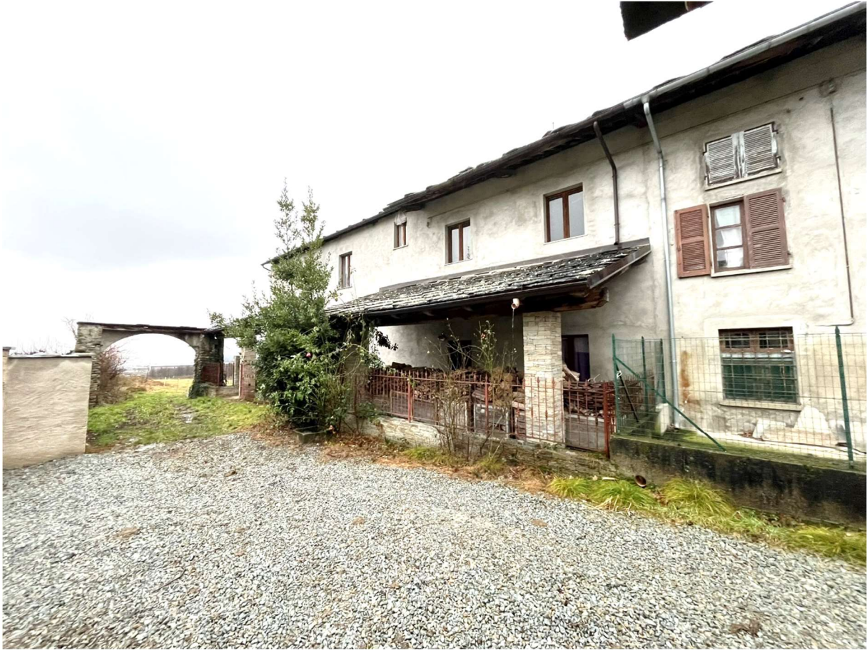
Foto n.2: Vista del prospetto nord del Bene n.1
