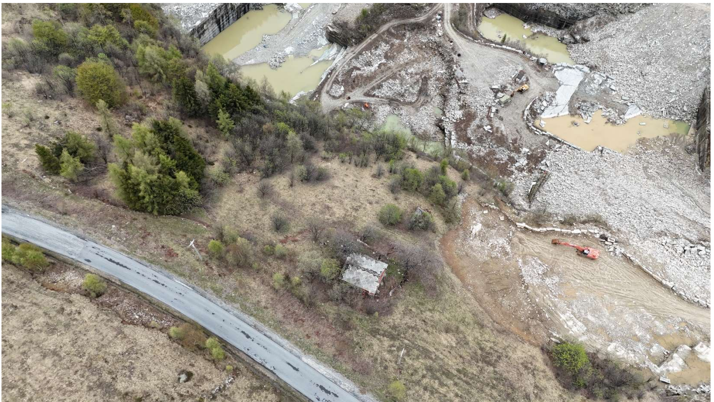
Foto n.1: Vista aerea da drone (sullo sfondo la cava "Bricco Volti")
