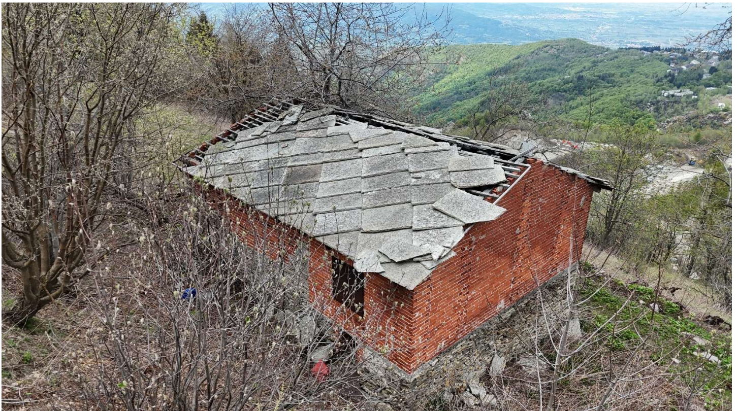
Foto n.7: Vista aerea da drone del fabbricato/rudere
