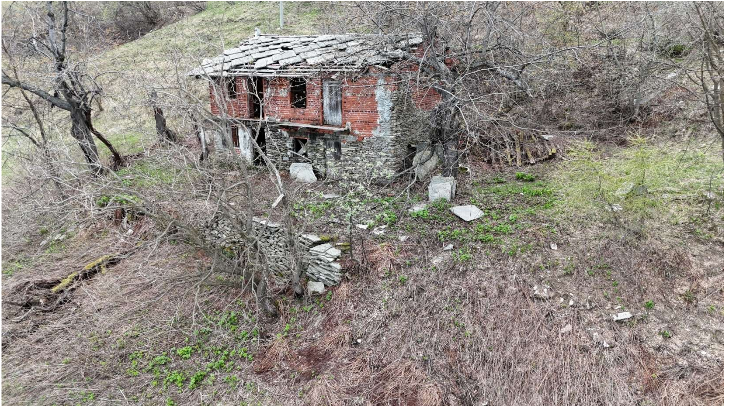
Foto n.6: Vista aerea da drone del fabbricato/rudere
