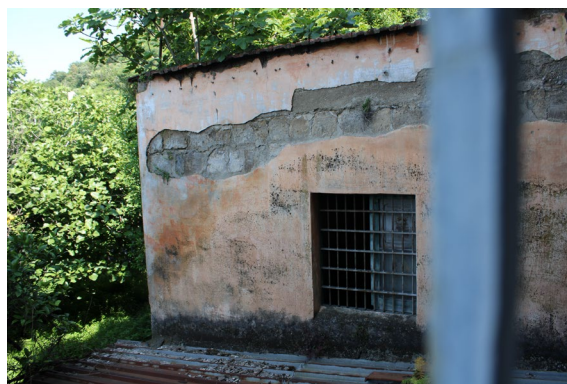
Figura 10 – Esterno Negozio – Lato Nord-Ovest
