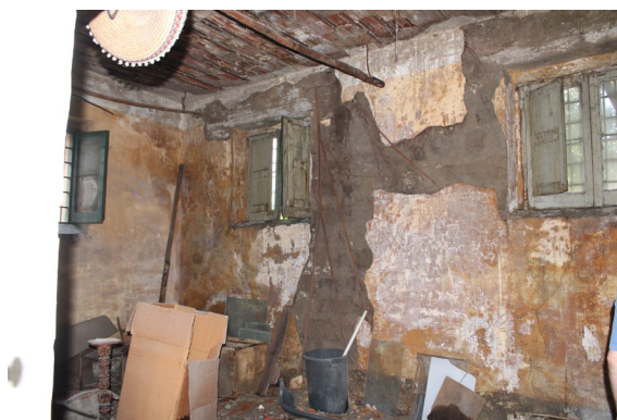
Figura 8 – Interno negozio – Lato Nord-Est
