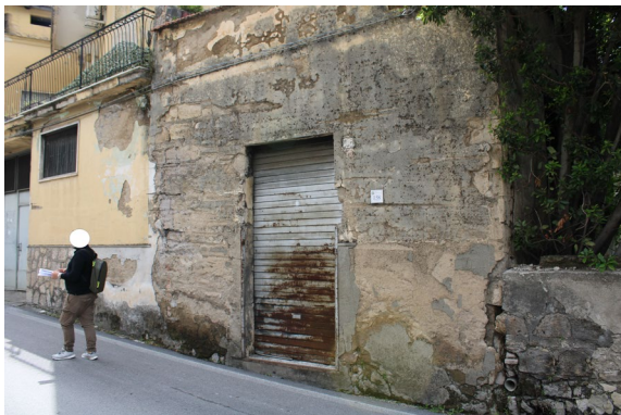
Figura 5 – Accesso negozio dalla strada
