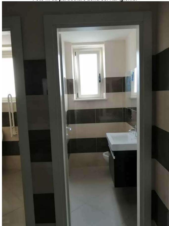
Foto n. 32 particolare zona servizi igienici -
