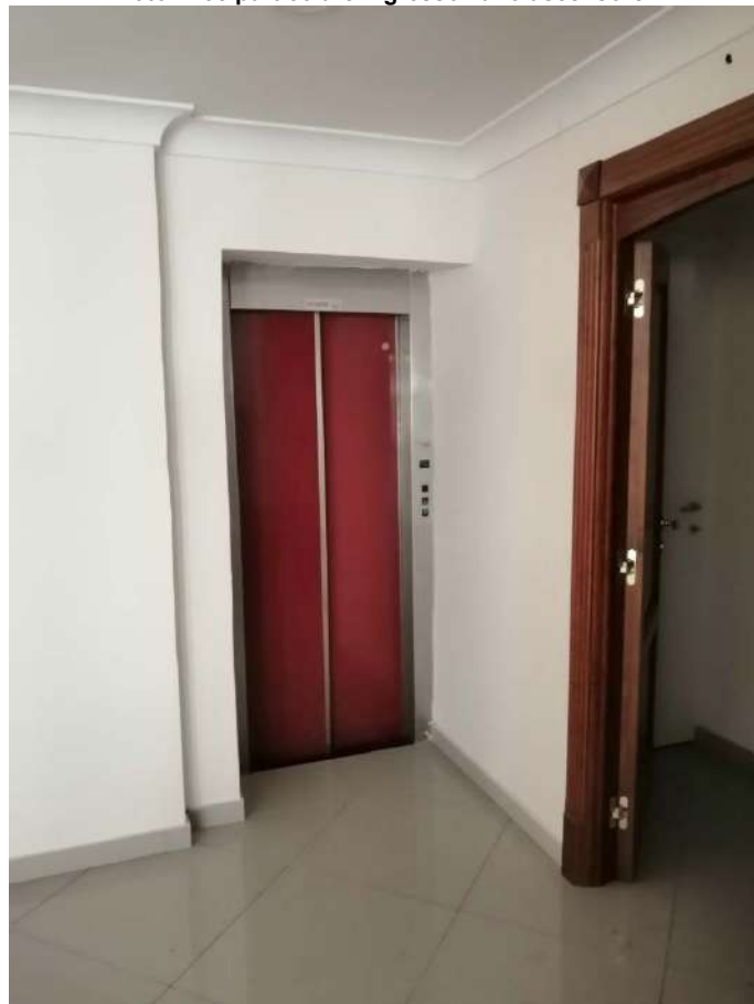
Foto n. 38 particolare ingresso vano ascensore-
