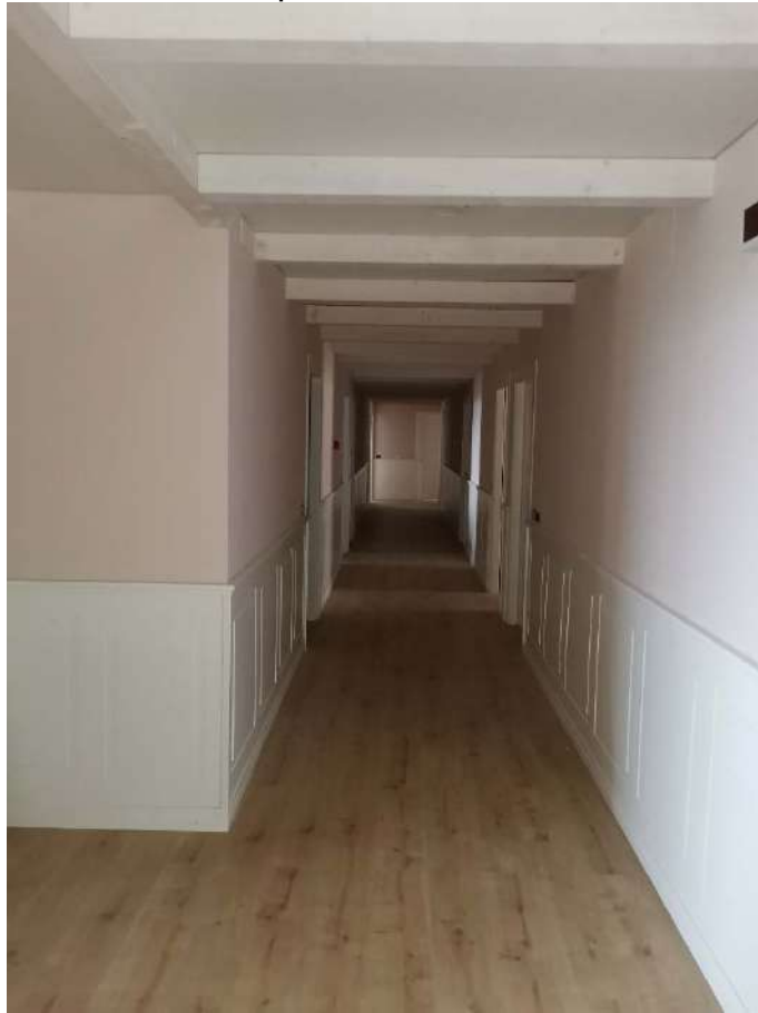
Foto n.41 particolare corridoio centrale
