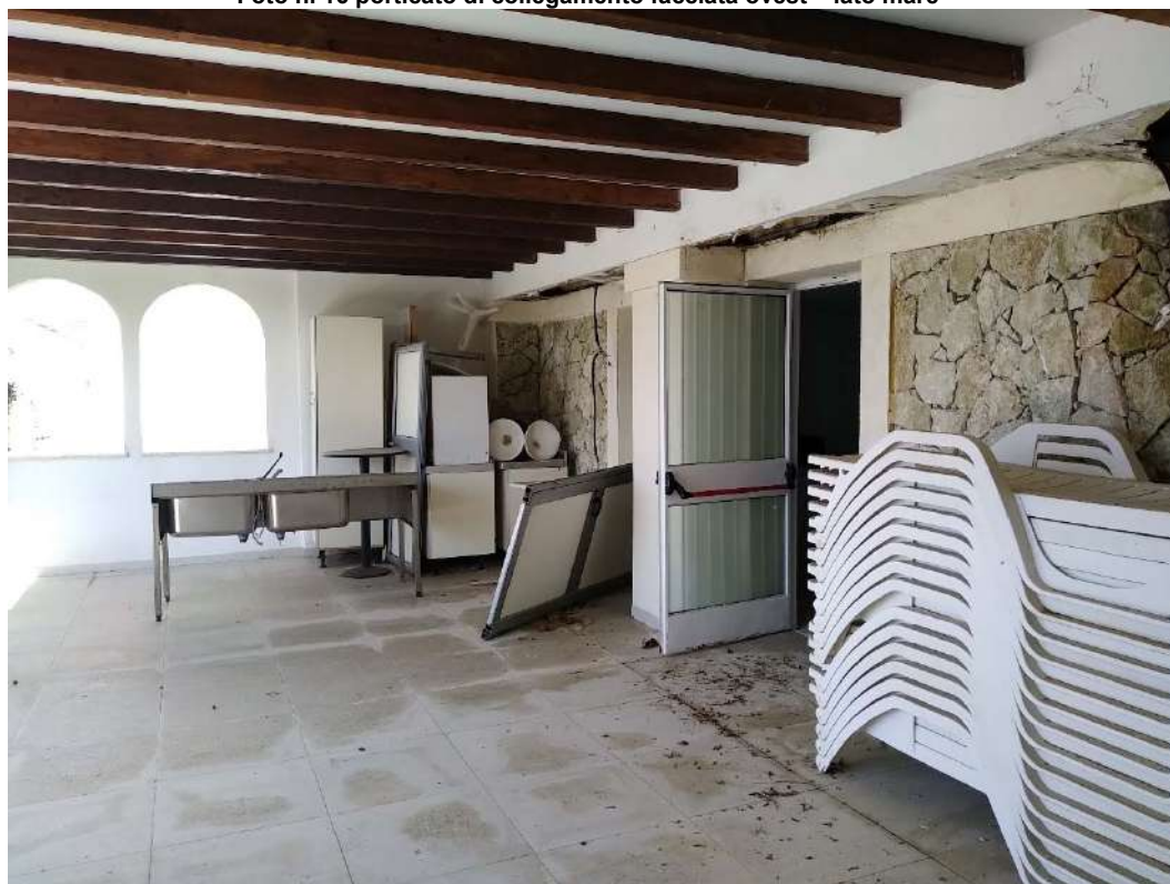
Foto n. 16 porticato di collegamento facciata ovest – lato mare -
