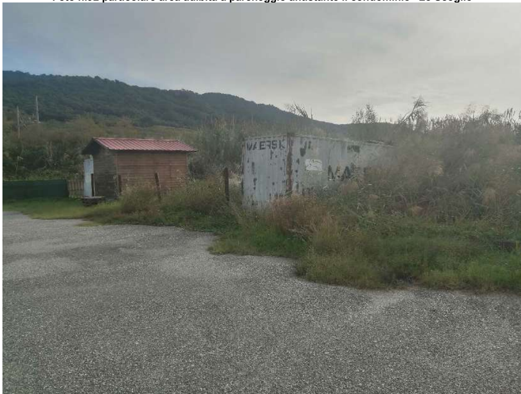
Foto n.92 particolare area adibita a parcheggio antistante il condominio "Lo Scoglio"
