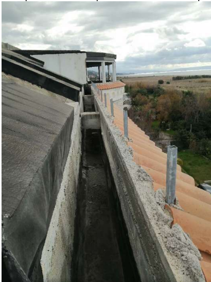
Foto n.74 particolare cornicione perimetrale esterno e falde di copertura
