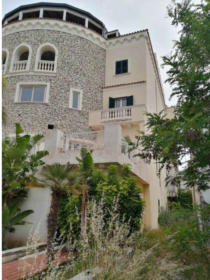
Foto n. 3 – particolare facciata ovest – lato mare -
