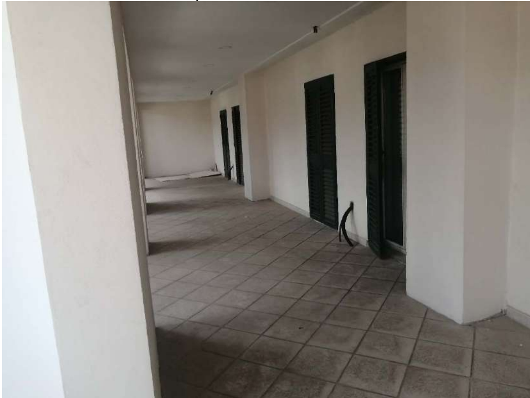
Foto n.60 particolare terrazzo lato Strada Statale
