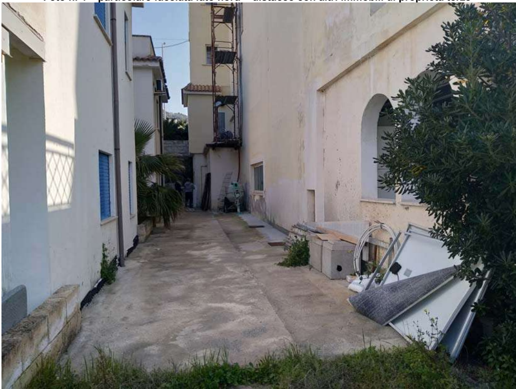
Foto n. 4 – particolare facciata lato nord – distacco con altri immobili di proprietà terze -
