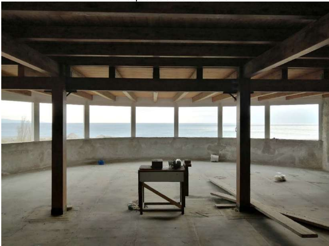
Foto n.63 particolare terrazzo lato mare
