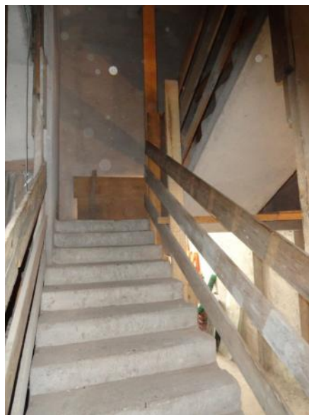
vano scala interno al grezzo
