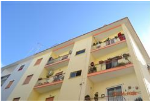
Particolare della facciata della Palazzina al Terzo Piano
