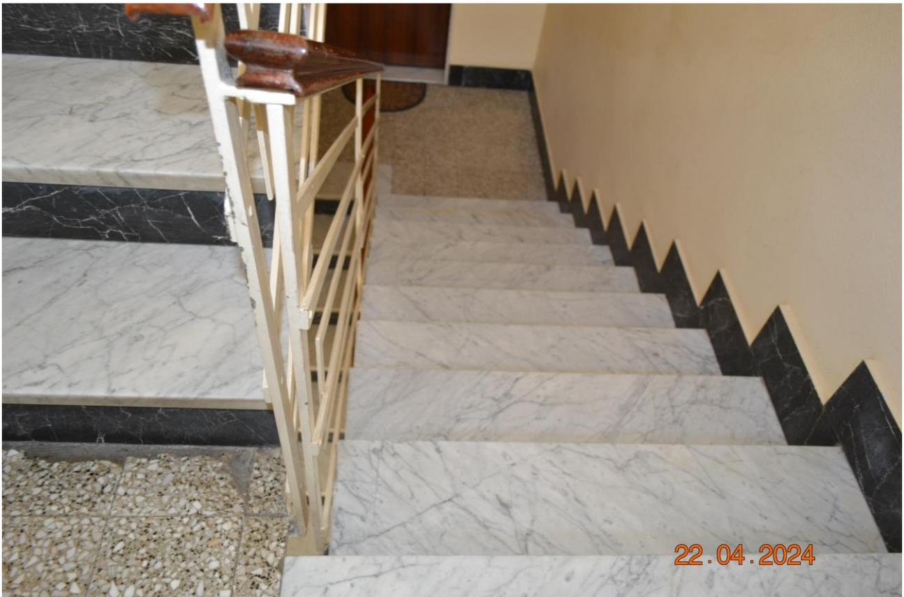
**FOTOGRAFIA 5:** Particolare dello stretto Vano Scala in cui non è possibile installare un ascensore
