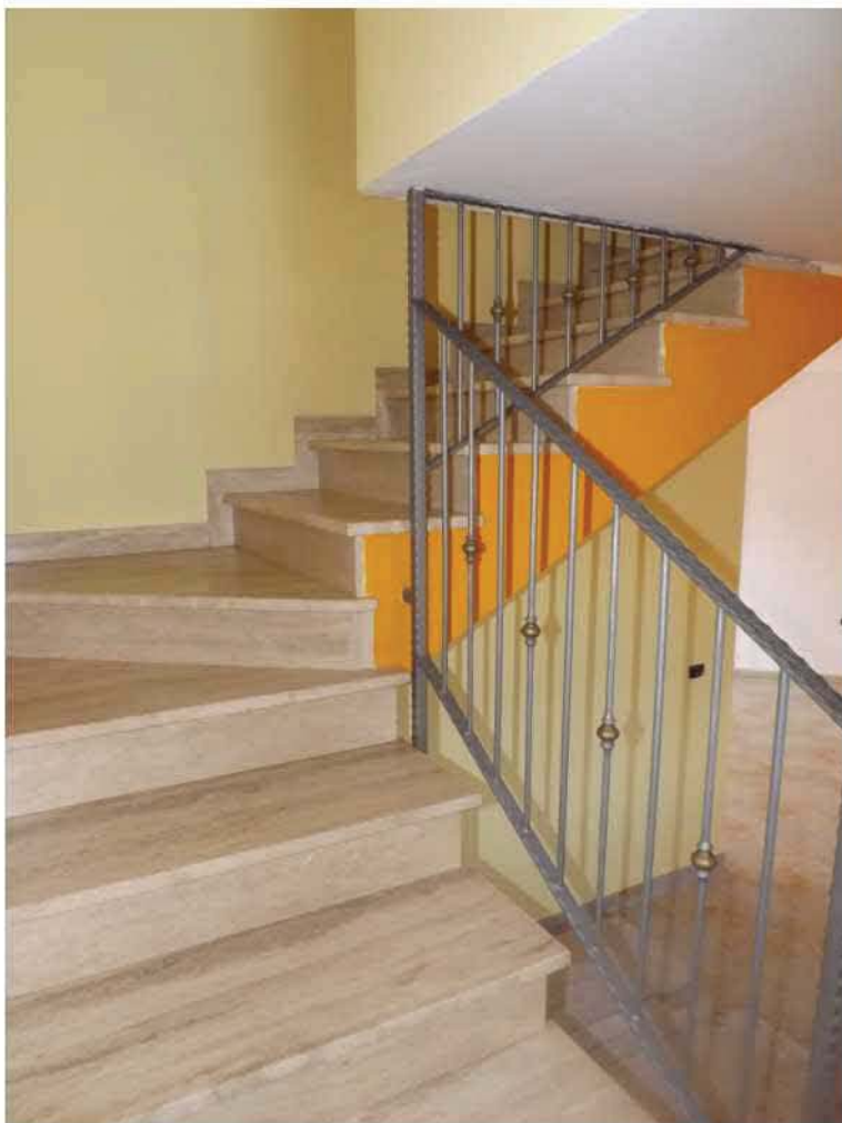
LA SCALA CHE CONDUCE AL SECONDO PIANO
