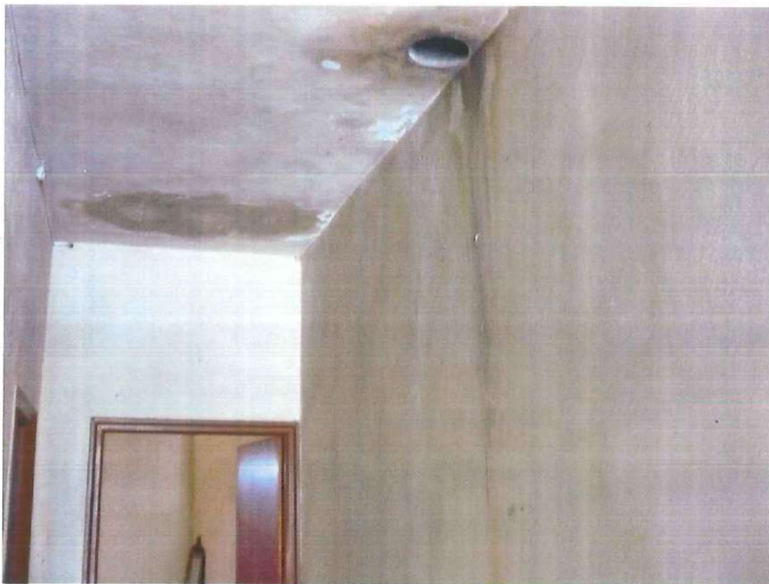
Foto n. 6 – Interno fabbricato particella 128 sub 3
