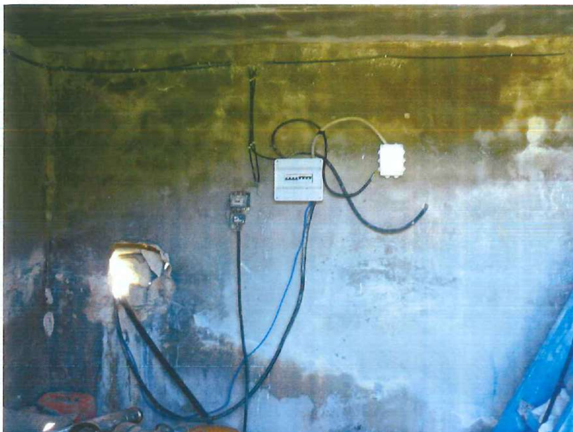
Foto n. 21 – Vano alloggio motore fabbricato particella 29
