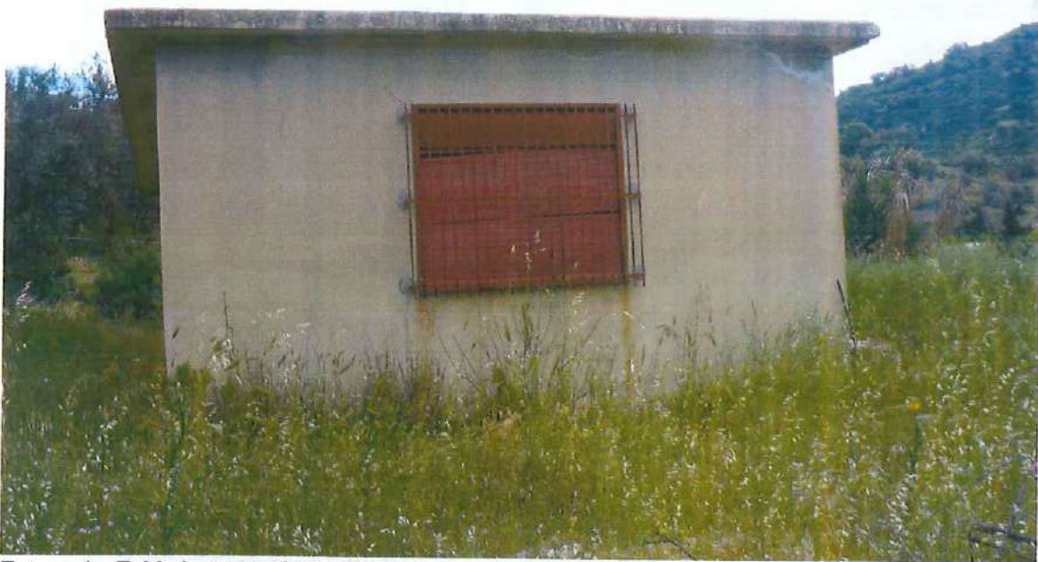
Foto n. 4 – Fabbricato particella 128 sub 3
