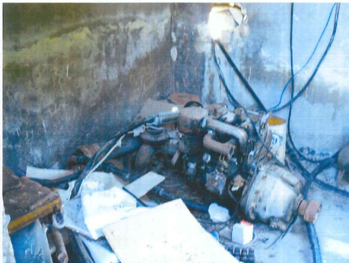
Foto n. 22 – Vano alloggio motore fabbricato particella 29
