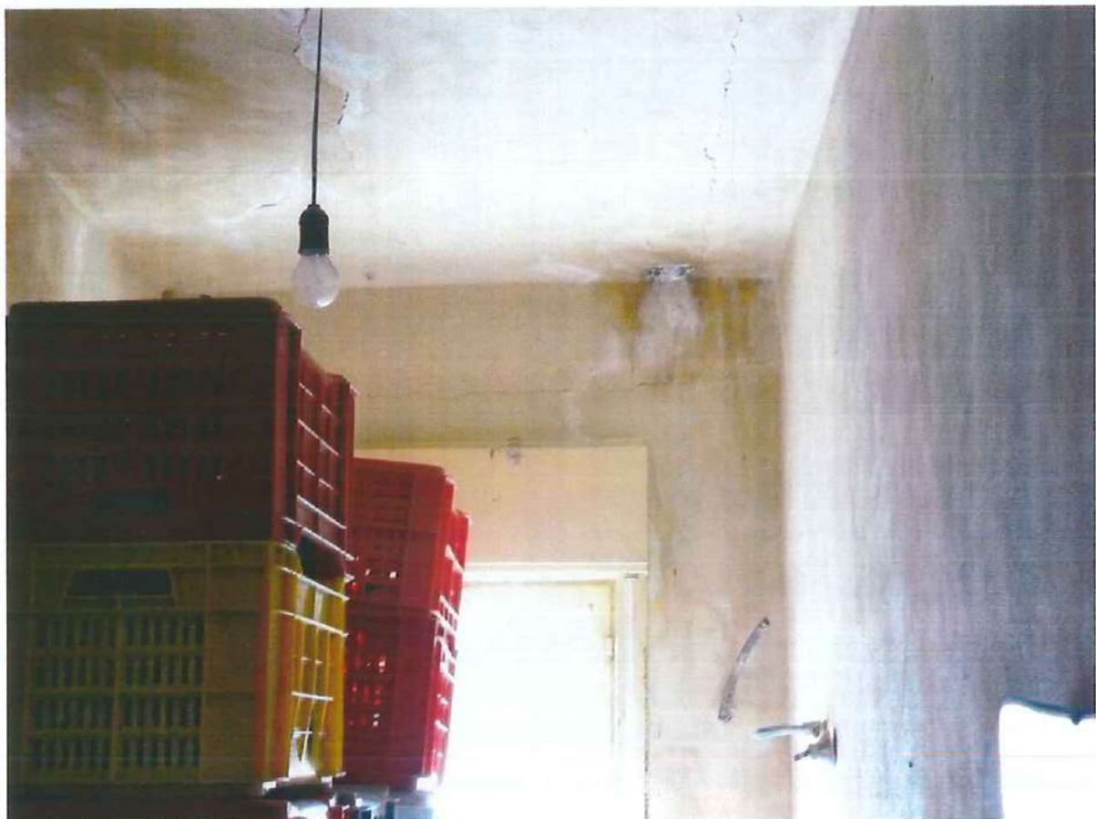
Foto n. 12 – Interno fabbricato particella 128 sub 3
