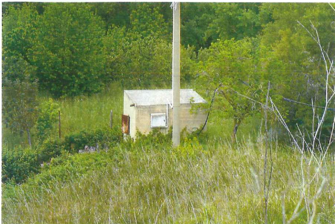
Foto n. 19 – Vano alloggio motore fabbricato particella 29
