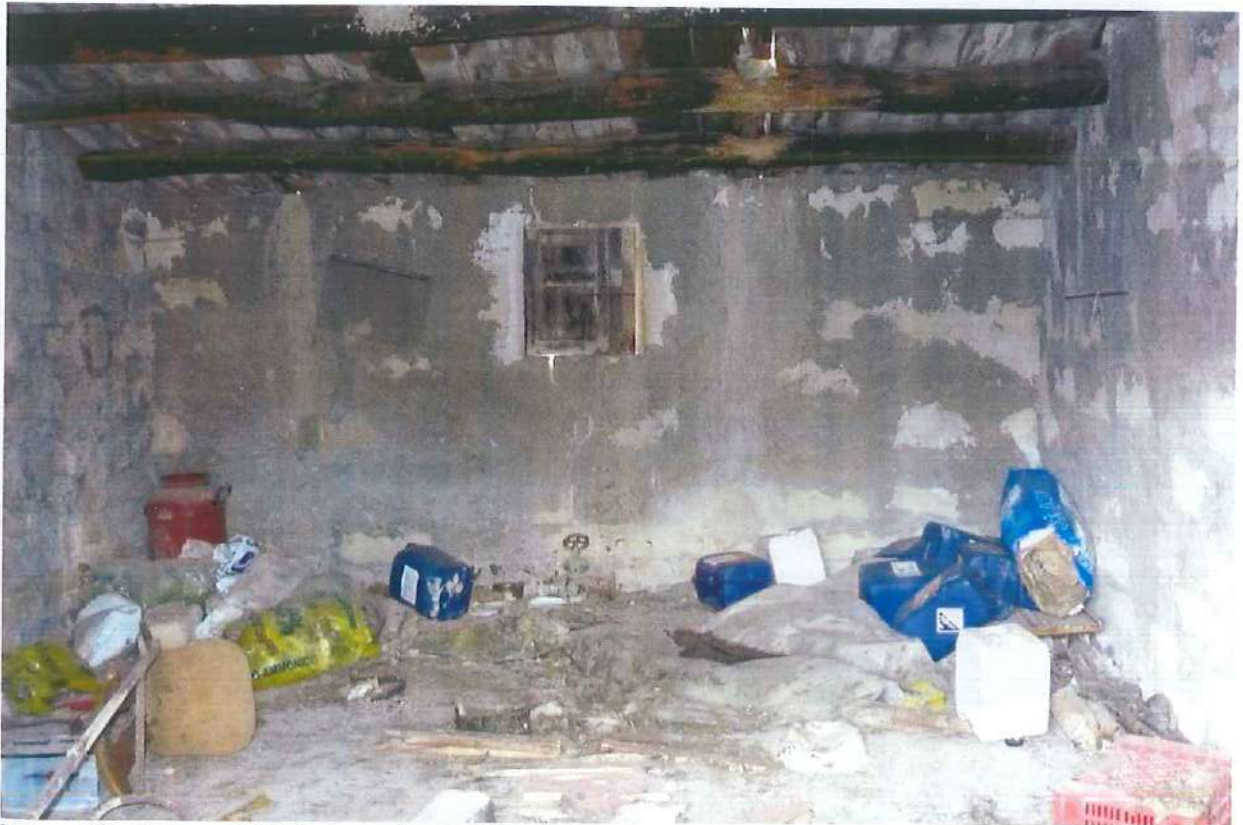
Foto n. 18 – Interno fabbricato particella 128 sub 4
