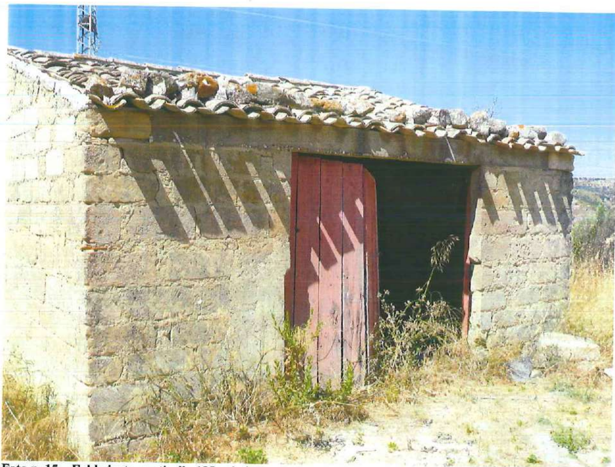
Foto n. 15 – Fabbricato particella 128 sub 4
