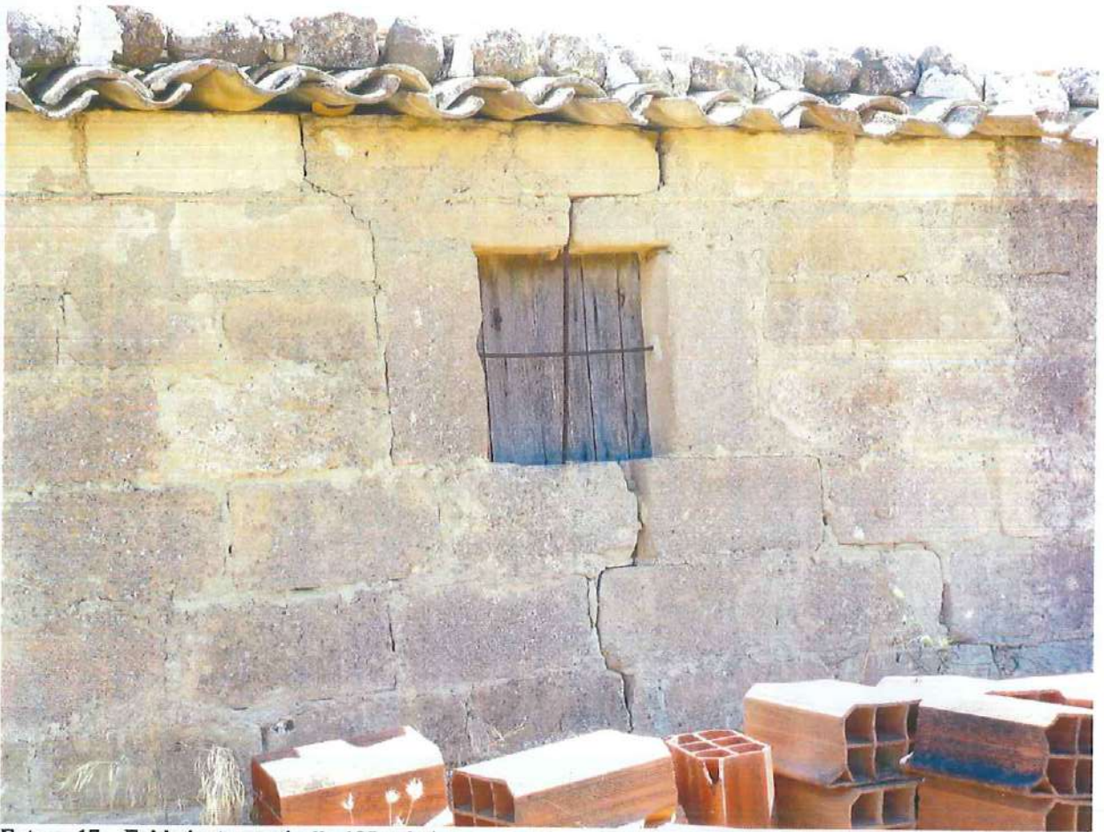
Foto n. 17 – Fabbricato particella 128 sub 4
