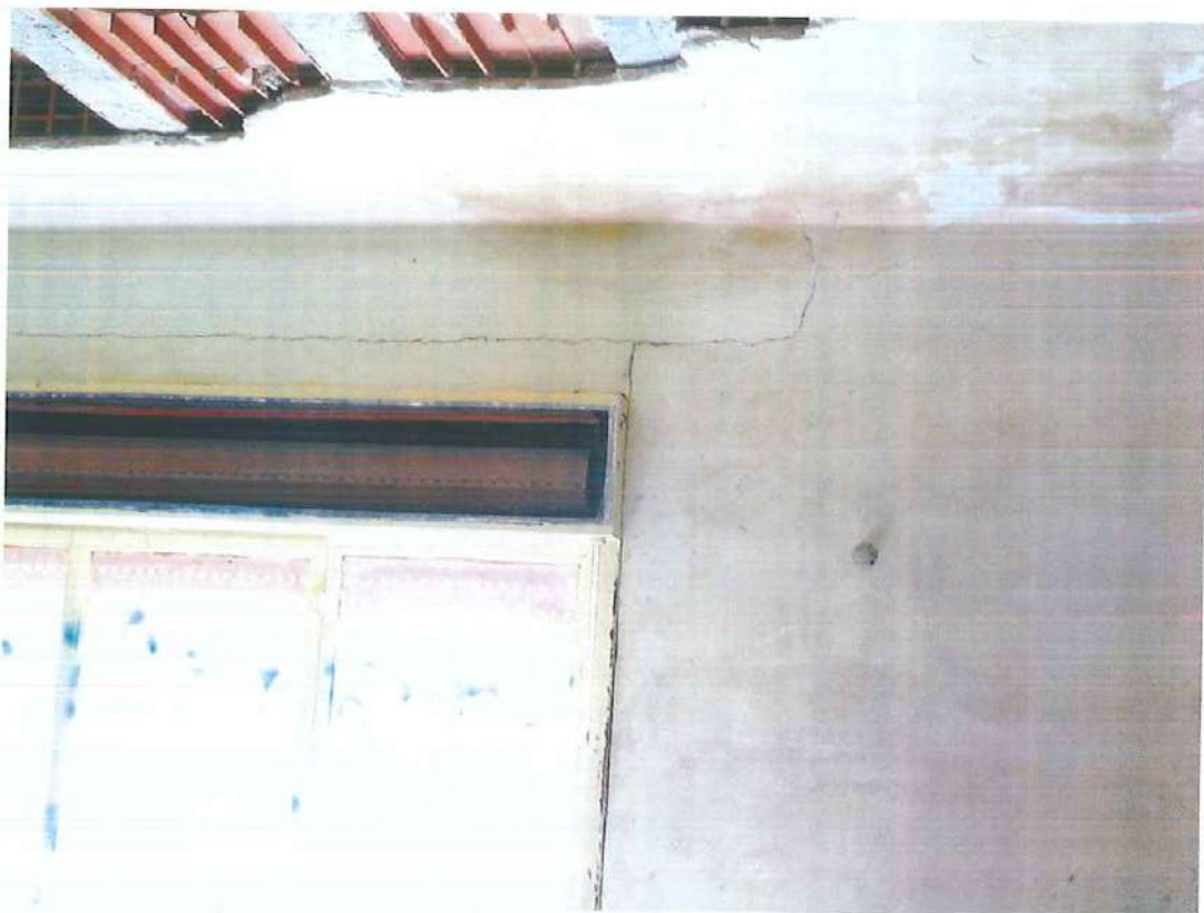
Foto n. 9 – Interno fabbricato particella 128 sub 3
