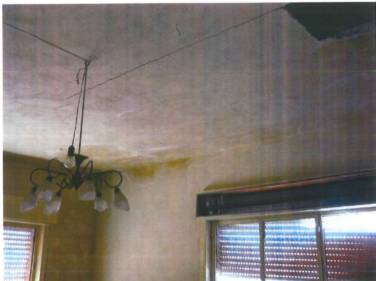
Foto n. 14 – Interno fabbricato particella 128 sub 3
