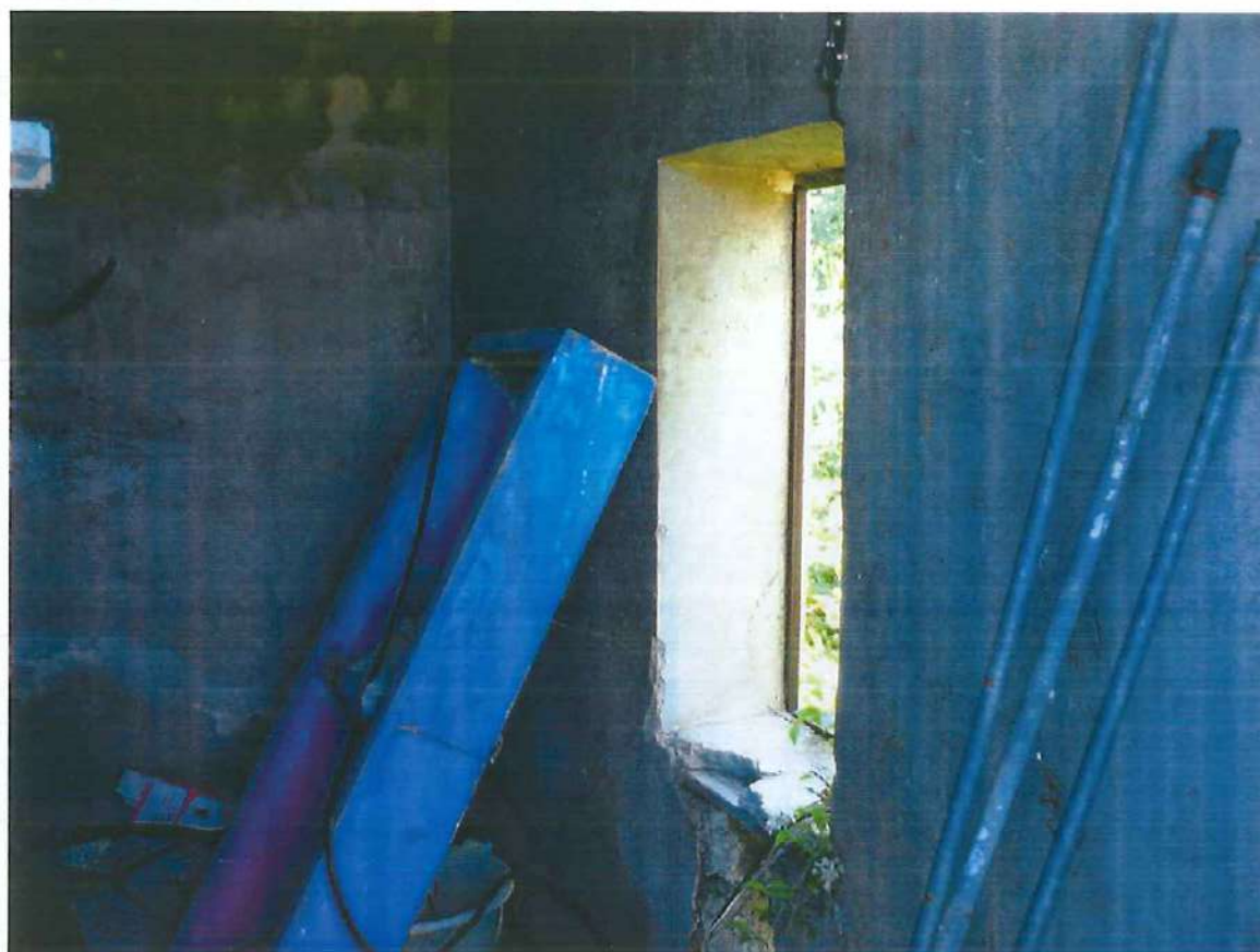
Foto n. 20 – Vano alloggio motore fabbricato particella 29
