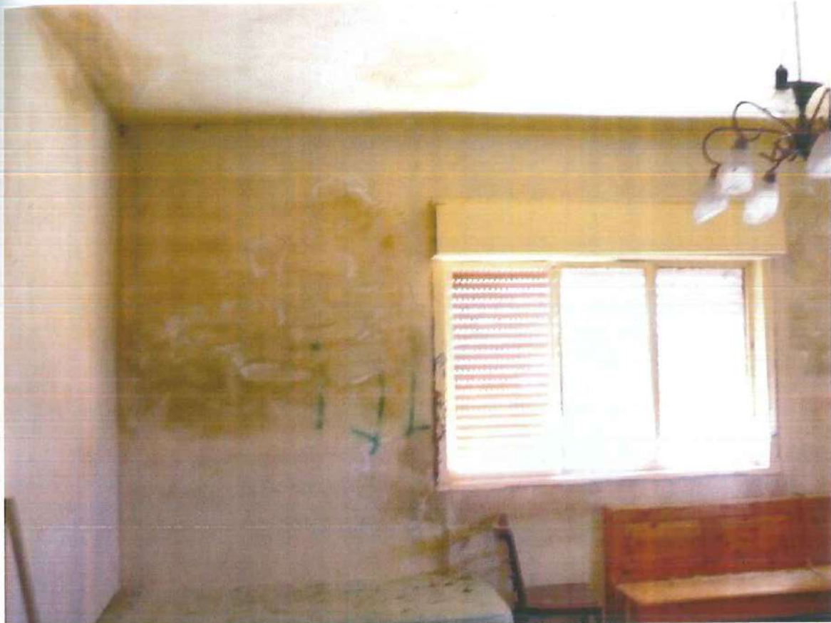
Foto n. 13 – Interno fabbricato particella 128 sub 3
