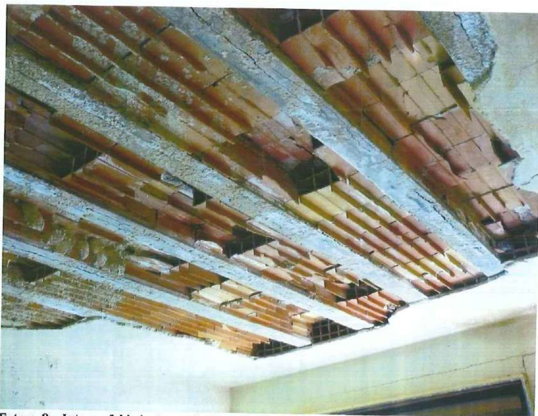
Foto n. 8 – Interno fabbricato particella 128 sub 3
