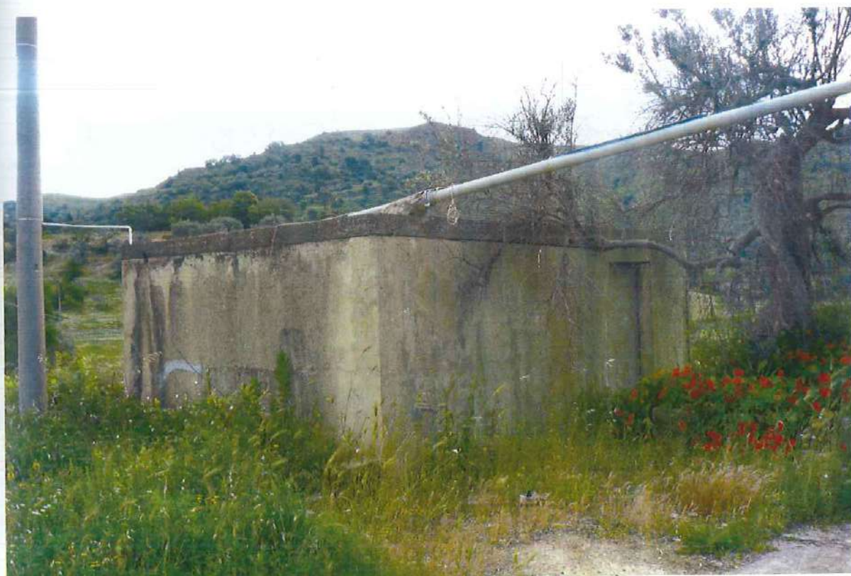
Foto n. 2 – Fabbricato particella 128 sub 2
