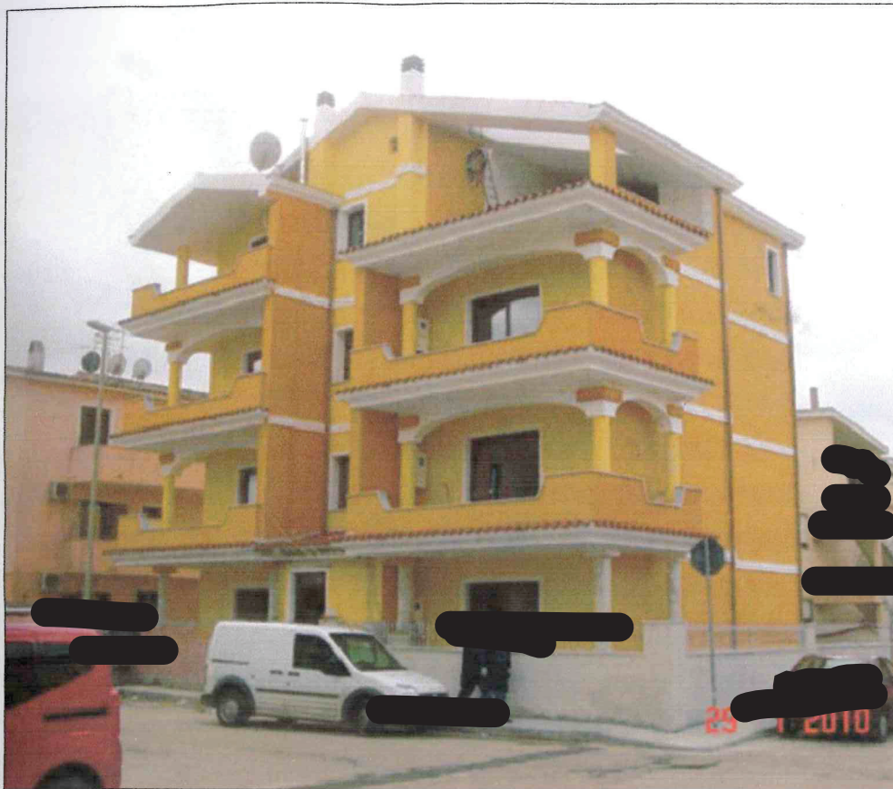
FOTO 1: prospetto principale, Via Ferrara angolo Via Teramo.
