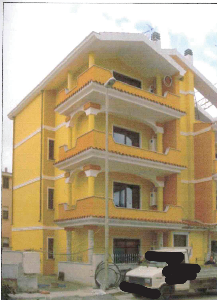
FOTO 2: prospetto principale, verso l'ingresso ai parcheggi di Via Ferrara.
