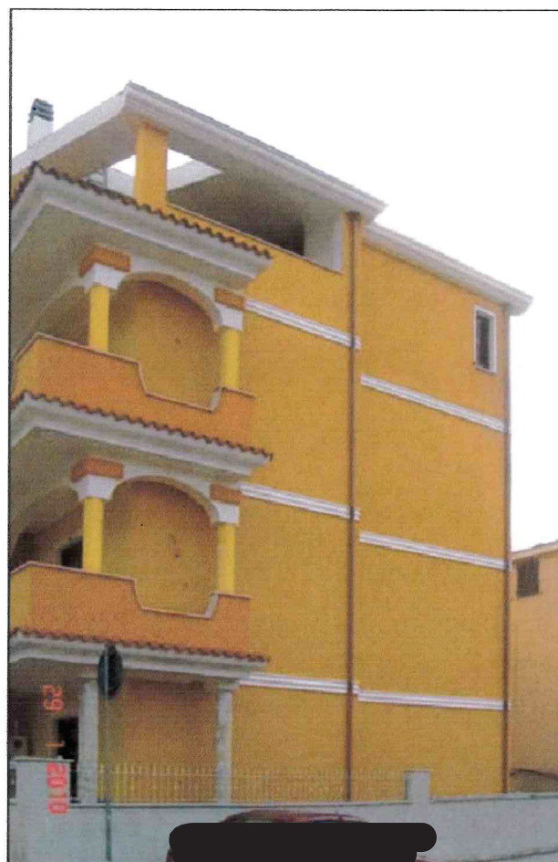
FOTO 6: prospetto laterale, Via Teramo.
