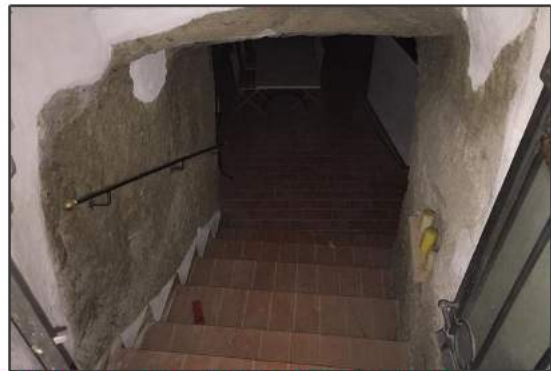
Foto 2 - accesso al magazzino sotterraneo
