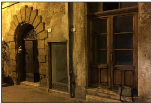
Foto 1 - Vista dell'accesso da Via Roma
