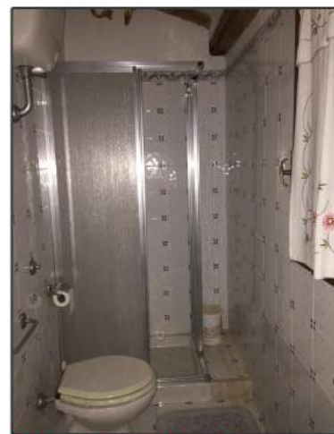
Foto 7 - Bagno al piano terzo
