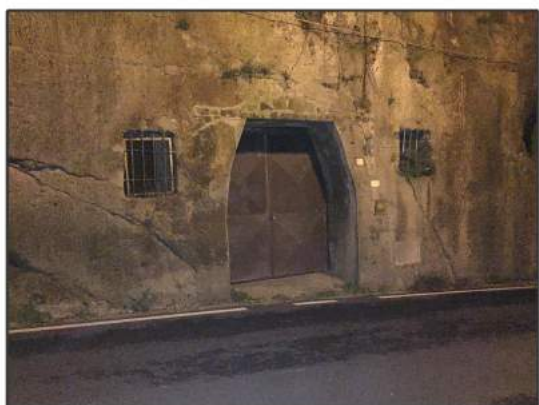
Foto 1 - Vista dell'accesso al magazzino
