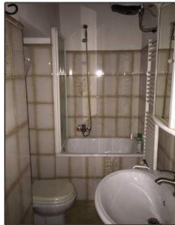
Foto 13 - Bagno al primo piano
