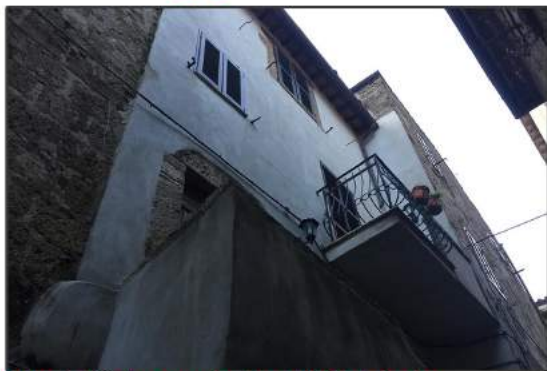
Foto 1 - Vista complessiva del fabbricato
