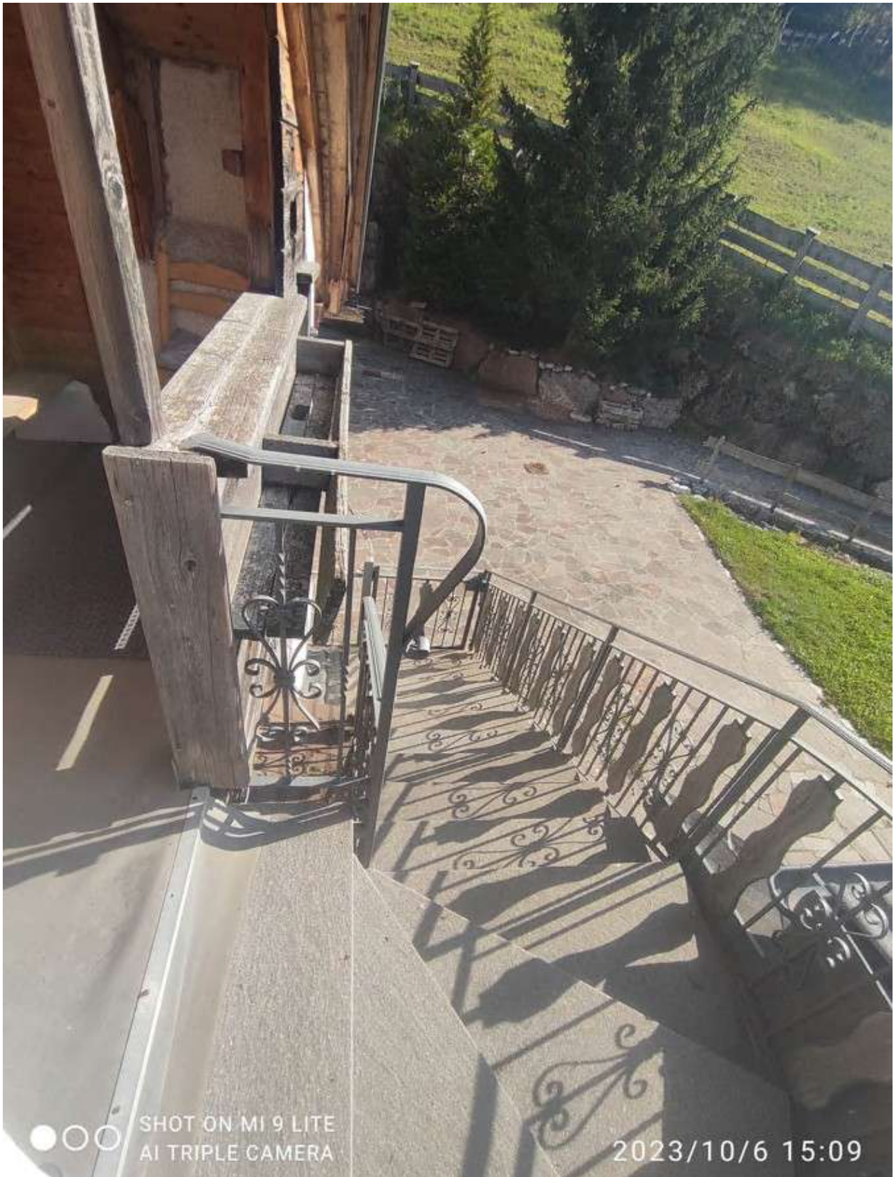
Figura 13: Scala che collega il poggiolo dell'appartamento con il piazzale retrostante l'ingresso principale.
