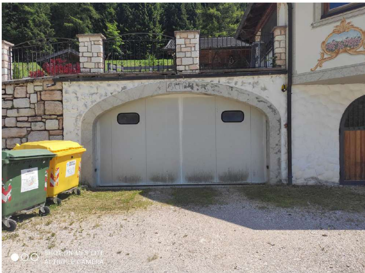
Figura 14: Portone sezionale a scorrimento di accesso al garage, visto dal piazzale.
