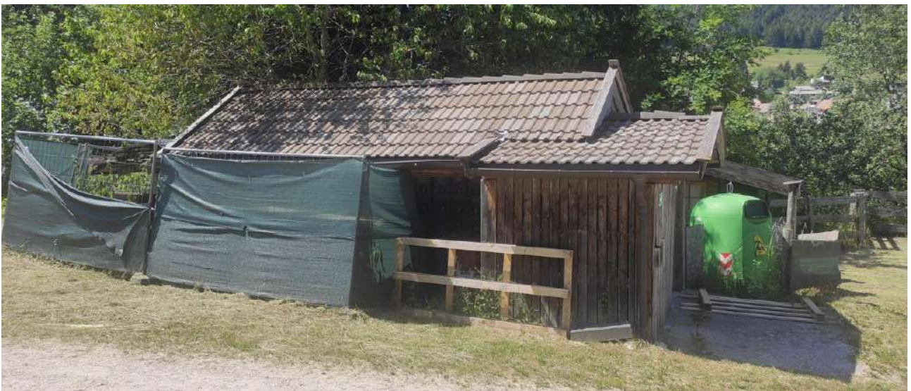
Figura 12: Deposito non censito.
