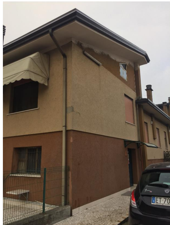
Scoperto su lato nord
