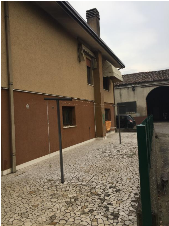
Scoperto su lato est
