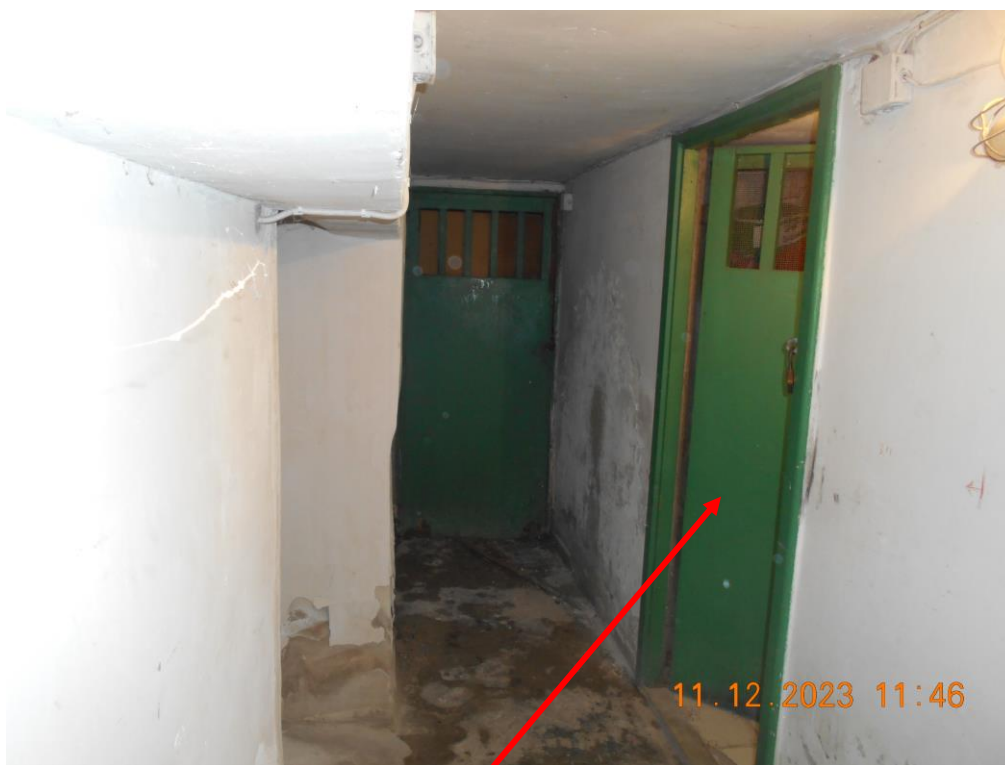
FOTO 17 – Corridoio comune piano sottostrada
