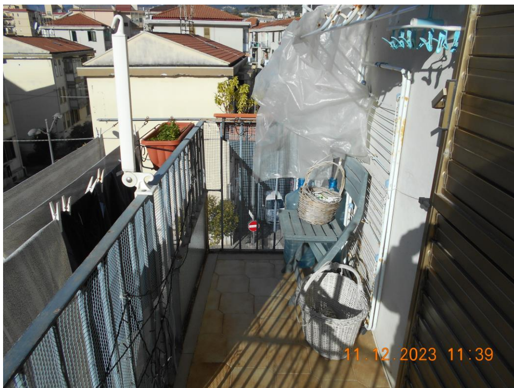
FOTO 8 – Balcone lato nord/ovest
