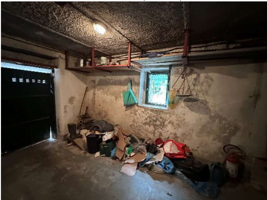
Foto 4 – Piano Terra (autorimessa)
