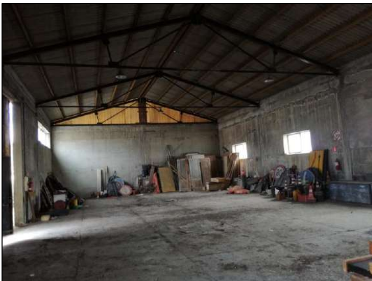
capannone ricovero automezzi
