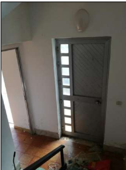
ingresso scala comune palazzina ufficio
