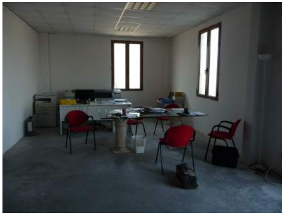
Foto 19 = ufficio (palazzina p.t.)
