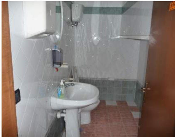
Foto 23 = bagno (palazzina p.t.)
