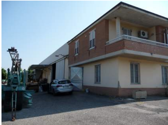
Foto 5 = vista dalla corte (lati sud - ovest)
