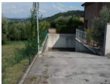
Foto 50 - via delle Danaidi - corte condominiale -
