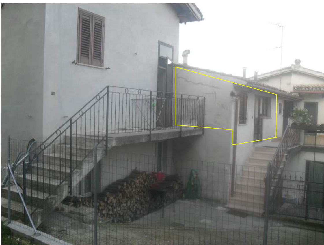
Foto n. 3 – Vista di parte della porzione di fabbricato oggetto di esecuzione (nel riquadro giallo)
