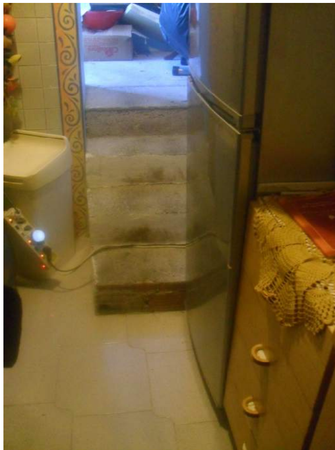
Foto n. 6 – Vista dell'ingresso alla porzione di fabbricato oggetto di esecuzione tramite scalini in muratura
