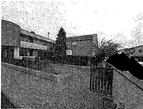
Vista resede condominiale da giardino
