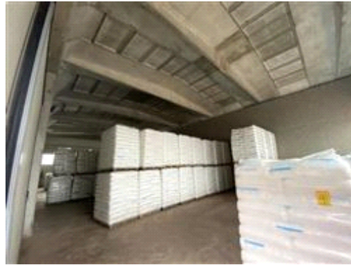
Tettoia parte centrale con grandi portoni coibentati
