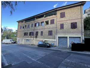
FOTO 2 - Prospetto Est Fabbricato
