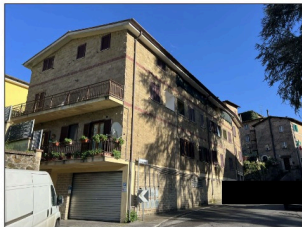
FOTO 1 - Prospetti Nord ed Est Fabbricato
