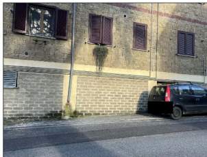
FOTO 3 - Prospetto Est fabbricato
