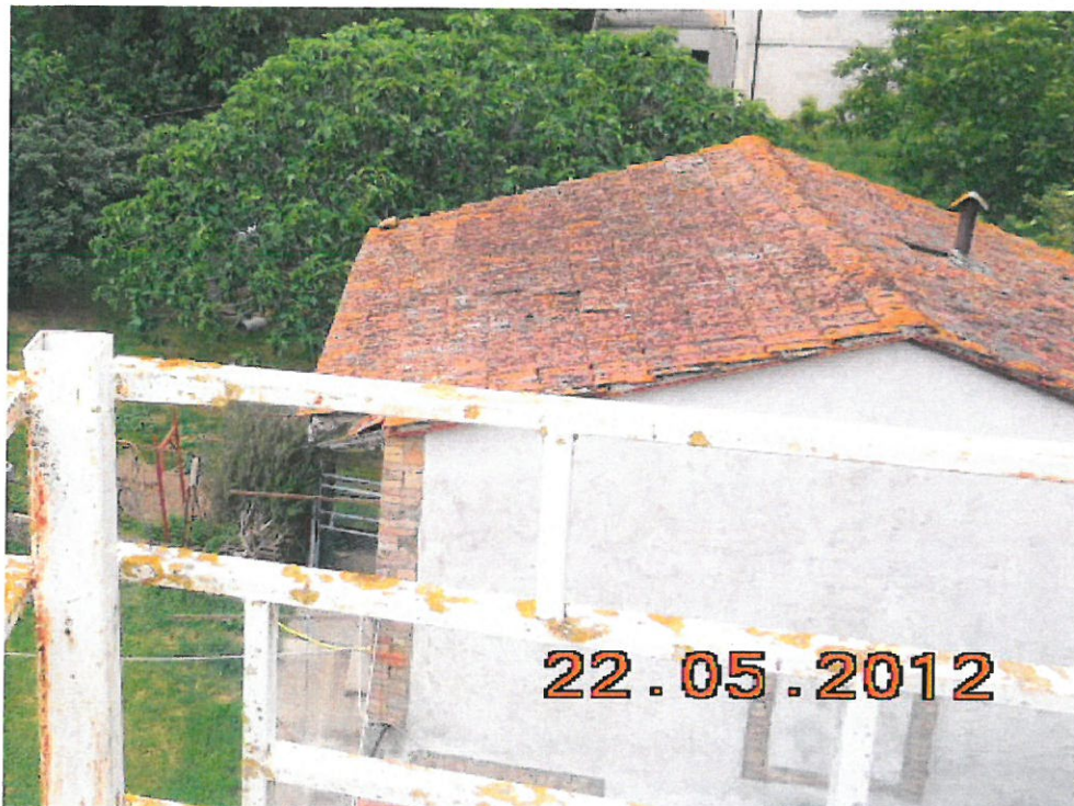
Foto n°28 – N.C.T. del Comune di Perugia, località Sant'Orfeto – Lotto "1"
