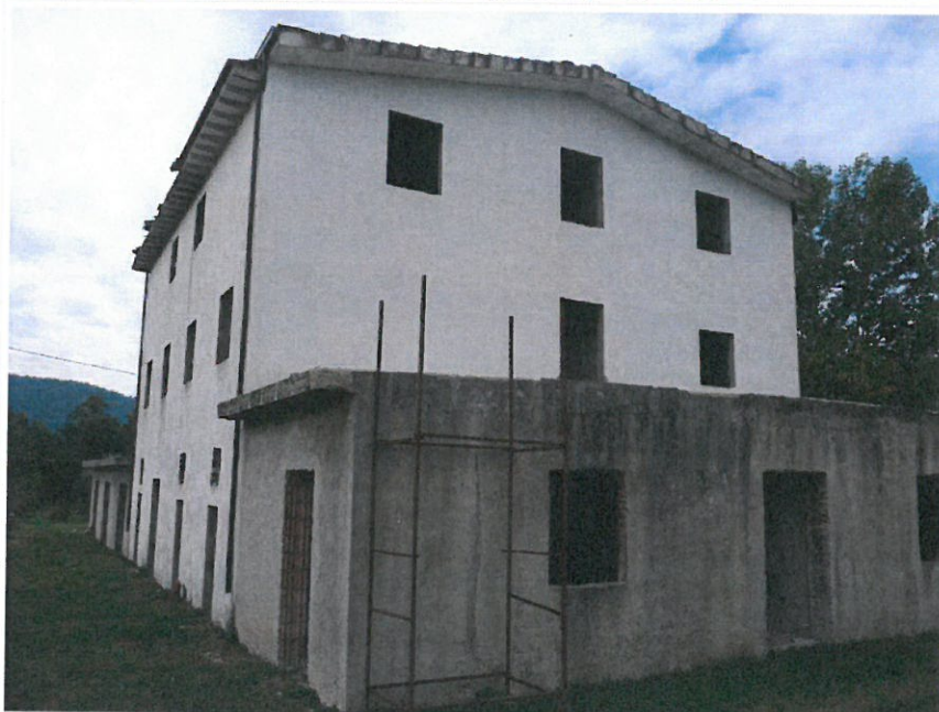
Foto 4. Esterno dell'edificio lato est
