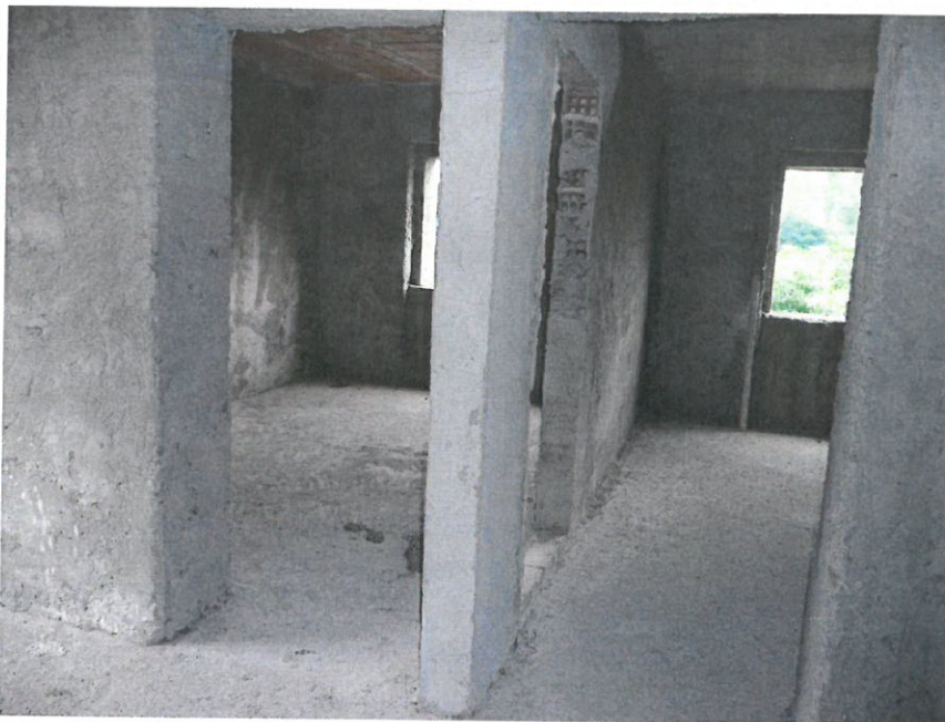
Foto 8. Stanze al piano primo
