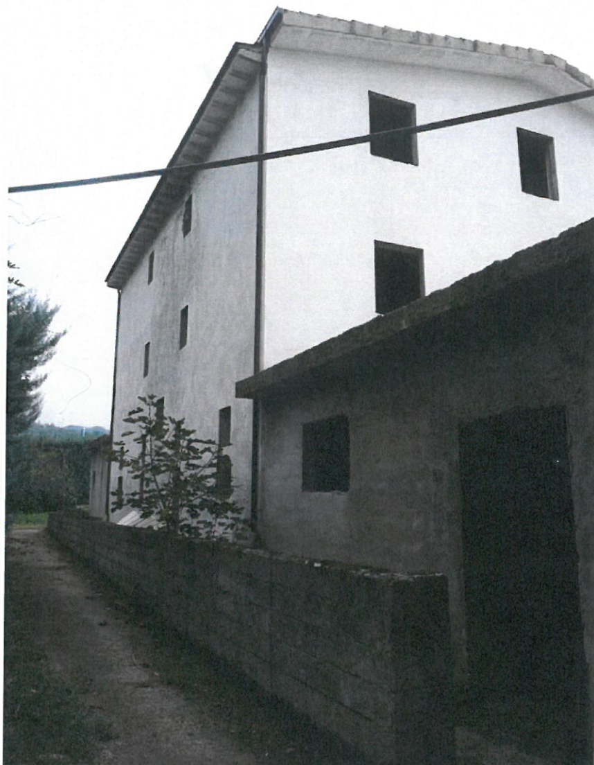
Foto 5. Esterno dell'edificio lato nord-ovest
