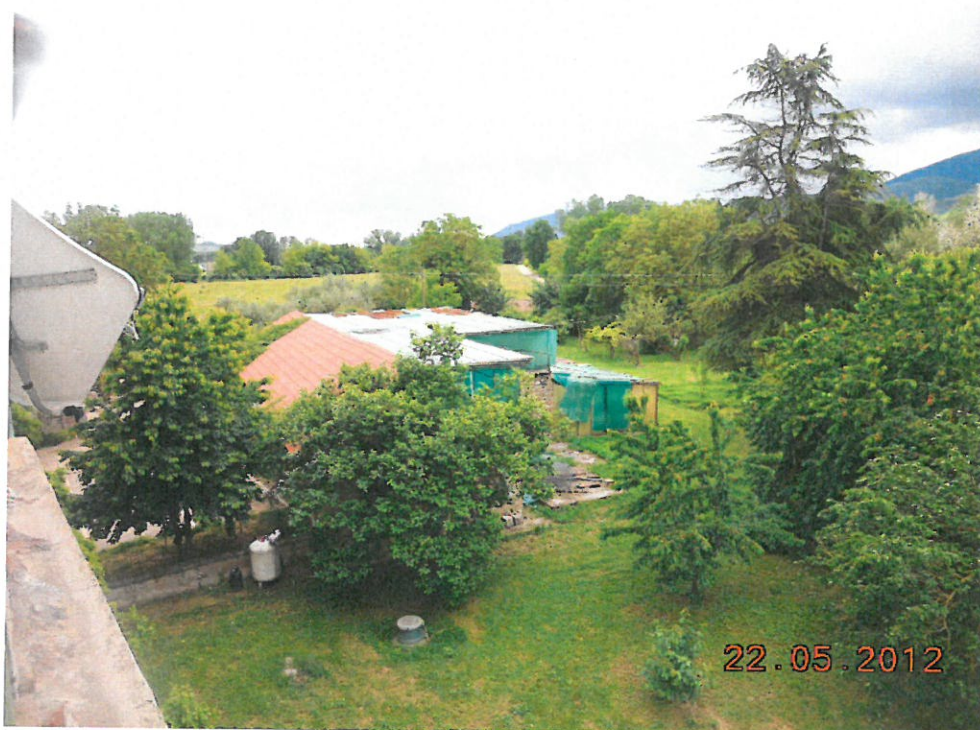
Foto n°29 – N.C.T. del Comune di Perugia, località Sant'Orfeto – Lotto "1" Foglio 10, particella 91 – Casale rurale A.3, vista da nord
