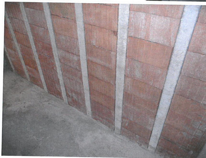
Foto 11. Particolare del solaio
