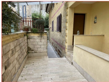
FOTO 4 - Passaggio esterno Condominiale
