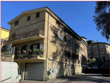
FOTO 1 - Prospetti Nord ed Est Fabbricato
