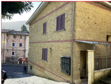
FOTO 3 - Prospetto Sud fabbricato con accesso su Via San Michele
