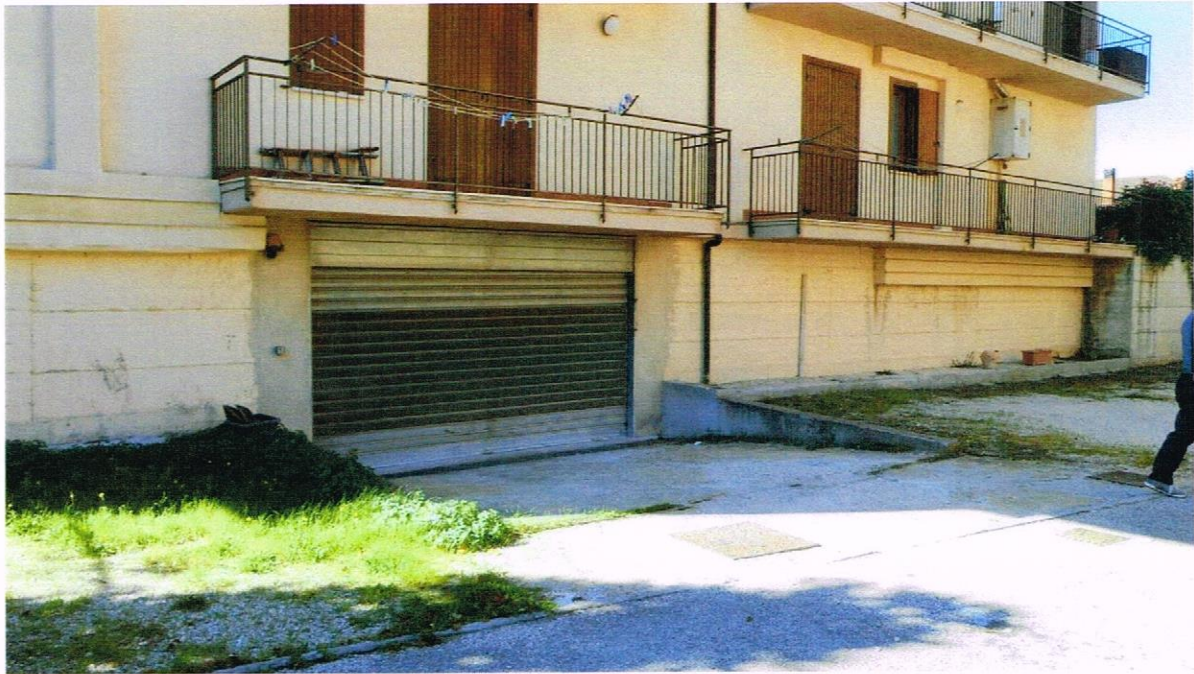
FOTO DELLA DELL'INGRESSO AL PIANO SEMINTERRATO
