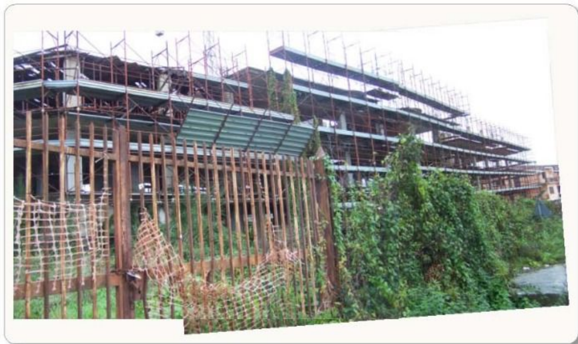
Vista esterna dell'ingresso verso il Lotto 1
