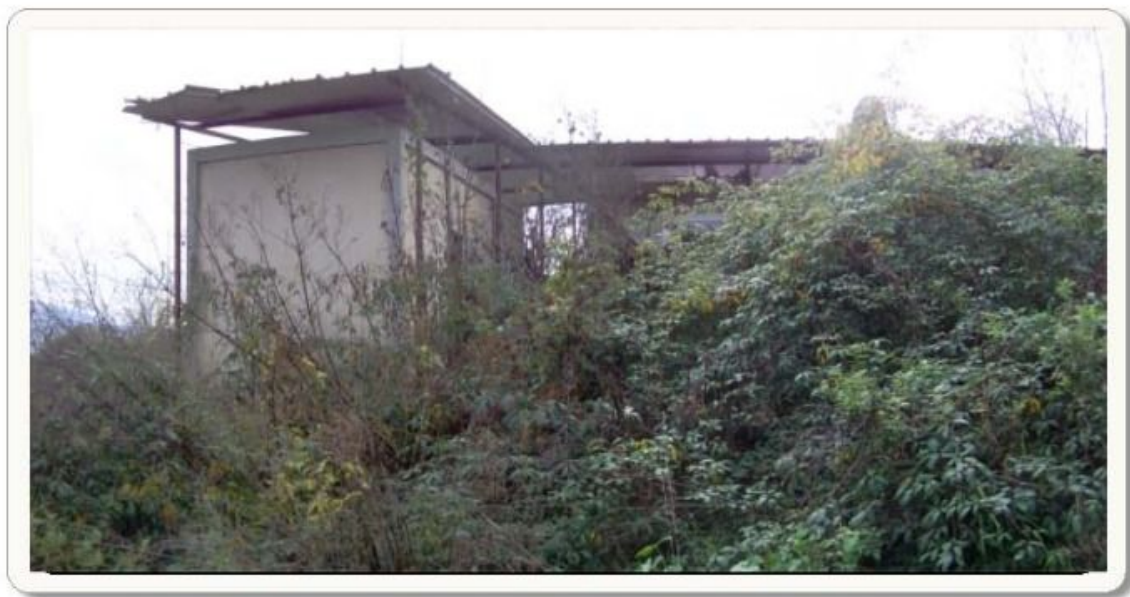
Vista delle baracche di cantiere all'interno del Piano di Lottizzazione
