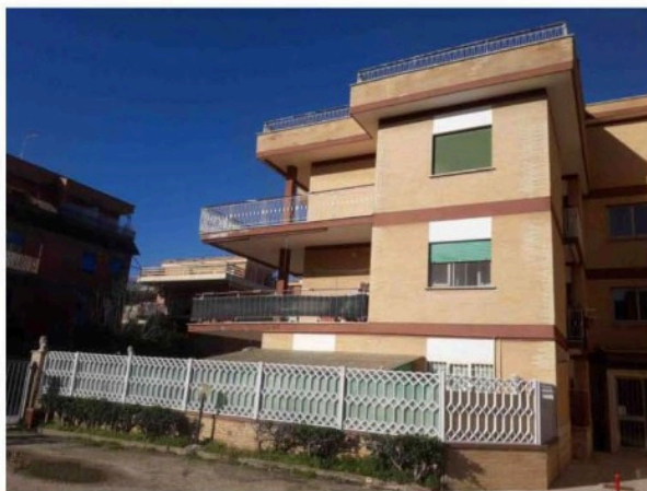
Foto 3 – Altra vista fabbricato condominiale
