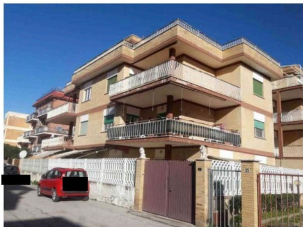
Foto 2 – Altra vista fabbricato condominiale.
