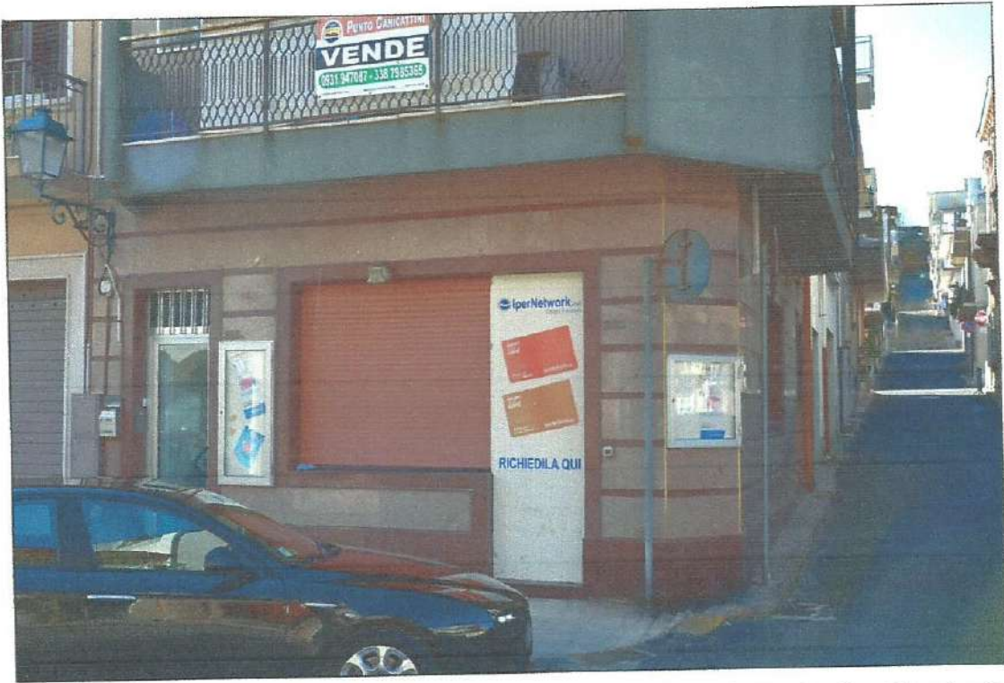
Fot.n°1: prospetto principale su Via Vittorio Emanuele, sulla dx la Via Regina Margherita.
