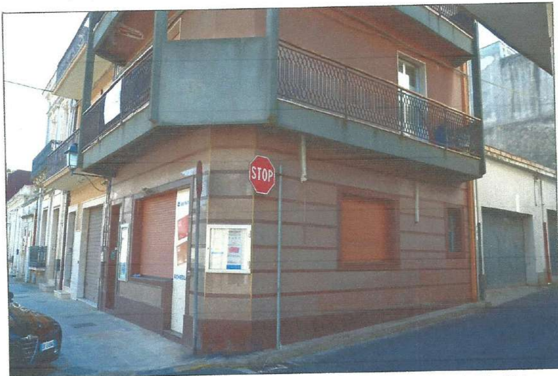
Fot.n°2: vista ad angolo tra Via Vittorio Emanuele (sx) e Via Regina Margherita (dx).
