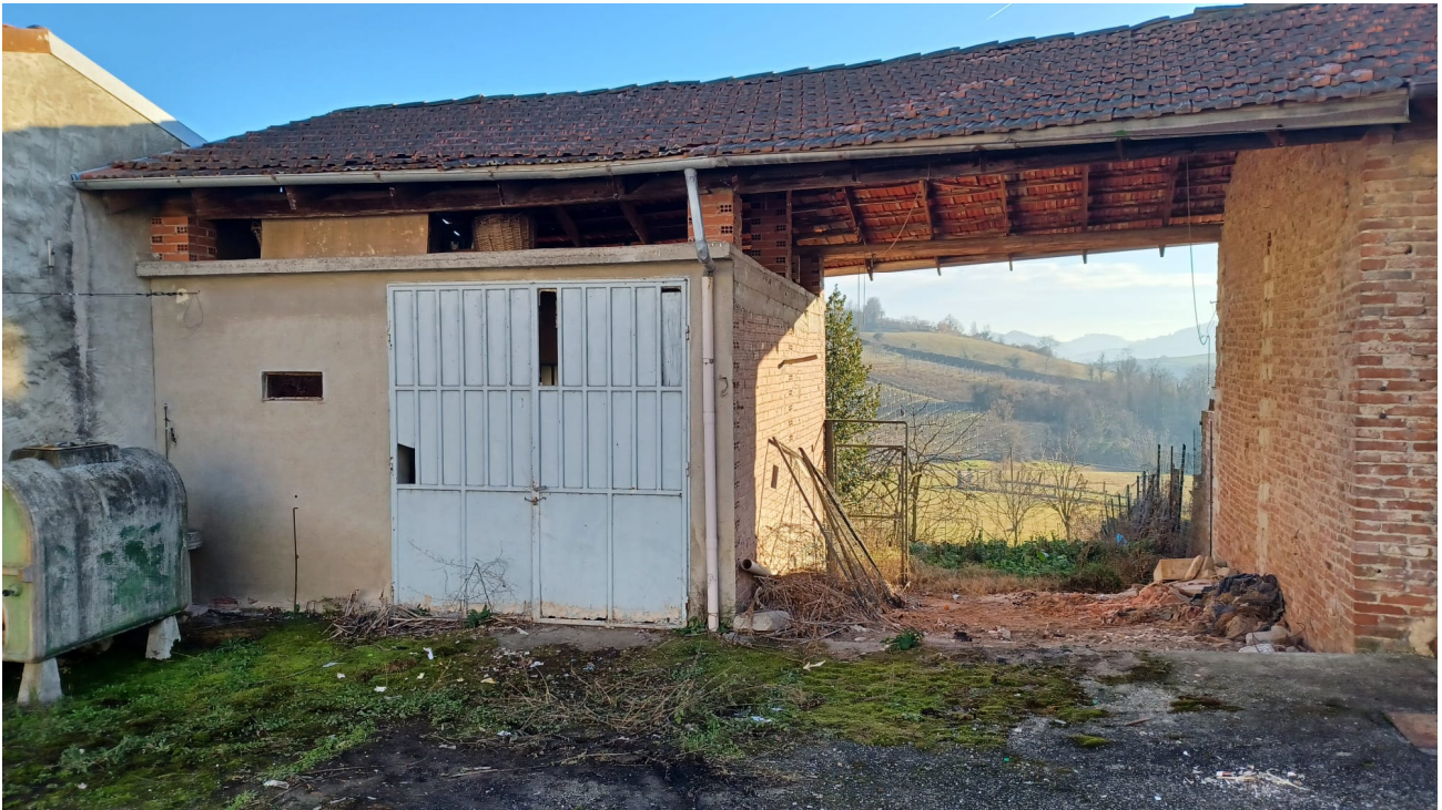
Foto 3 – vista da cortile – fabbricato accessorio -
