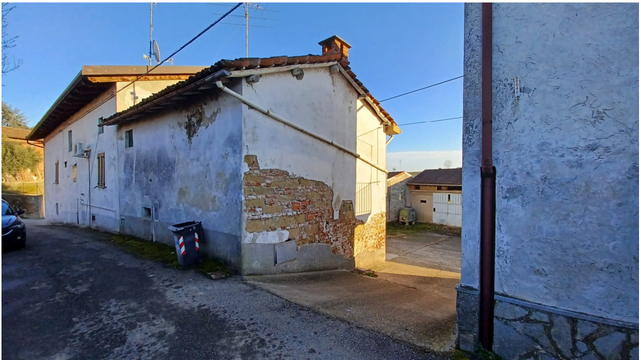
Foto 2 – vista da strada
