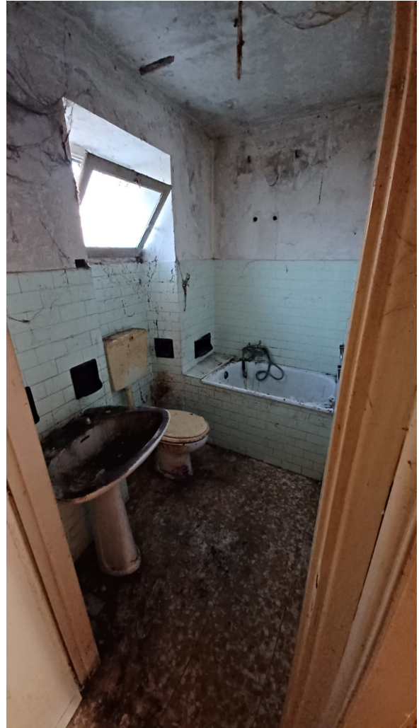
Foto 8 – bagno piano primo
